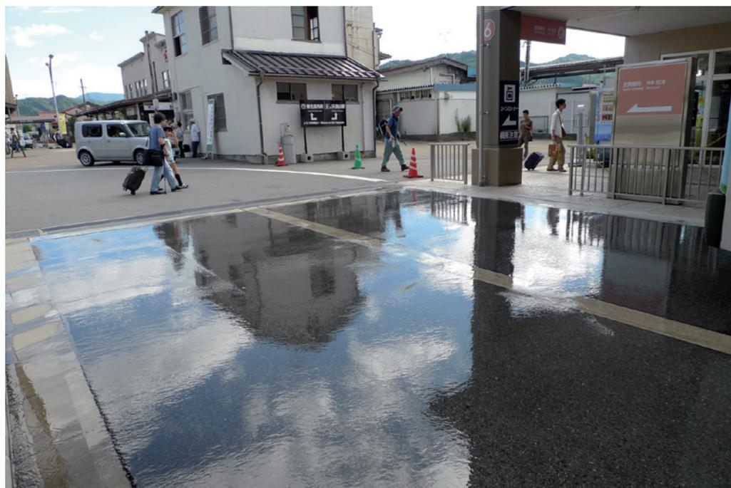
Lame d'eau créée par aspersion continue de façon à améliorer le confort thermique à proximité d'une gare routière (Japon, août 2012). Les dispositifs d'arrosage sont intégrés au revêtement de sol. Le revêtement est conçu de façon à avoir une certaine porosité afin de maximiser les surfaces d'évaporation et donc le rendement de la mesure d'adaptation.
