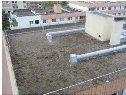
Toiture terrasse recouverte de graviers : la grande quantité d'air prisonnière entre les graviers confère peu de capacité de stockage du rayonnement solaire à ces toits ce qui est un atout climatique.
