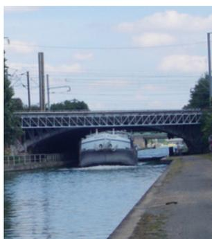
Bobigny : pont métallique ferroviaire, tirant d'air : 4,30 mètres
