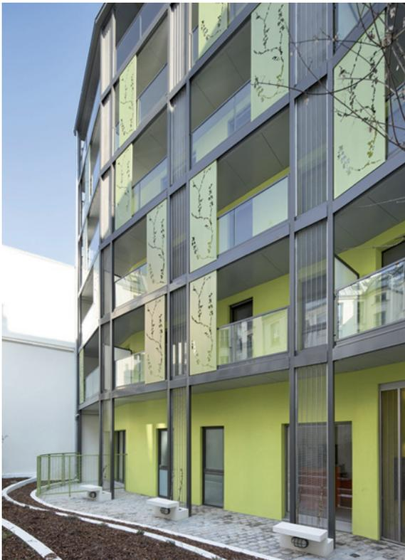
Pour produire plus d'énergie qu'il n'en consomme, ce bâtiment très compact (Paris 11<sup>e</sup>) de 17 logements sociaux, met en œuvre traitement des ponts thermiques, isolants épais, capteurs solaires thermiques et photovoltaïques. RIVP maître d'ouvrage, Baudouin Bergeron architectes.
