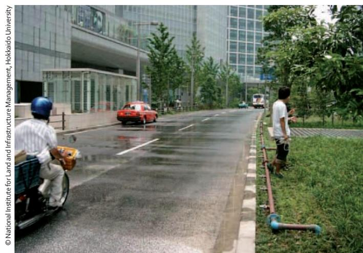
Système de rafraîchissement par aspersion utilisant les eaux usées traitées, Tokyo, Japon
