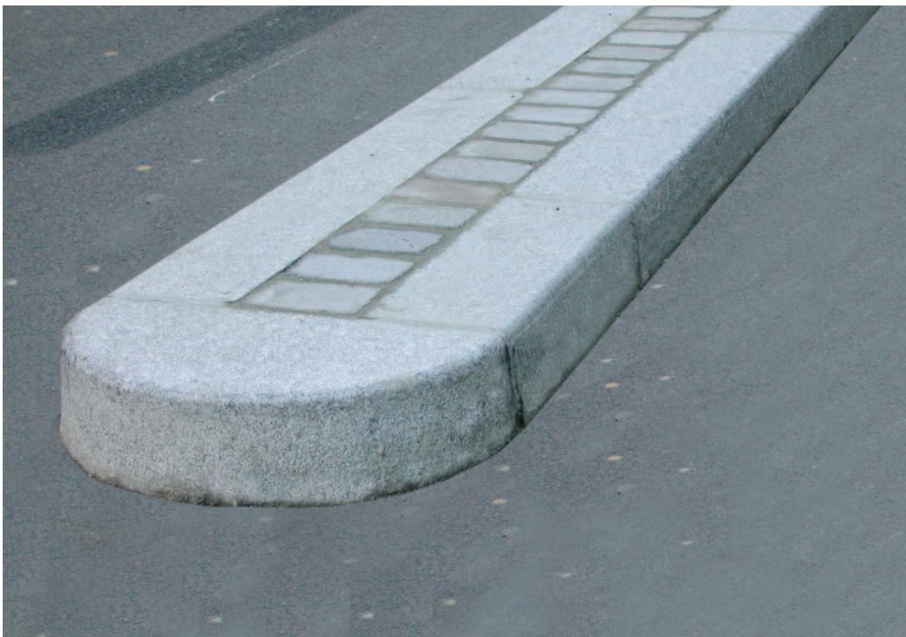
Le béton coulé en place doit être évité, les bordures en granit sont préconisées. Pour des raisons de sécurité, surtout pour les deux-roues motorisés, le séparateur étroit d'environ 30 cm de largeur pourrait être équipé de catadioptres. Les catadioptres permettent de nuit de bien identifier les espaces et participent aussi au paysage nocturne de la voie.
