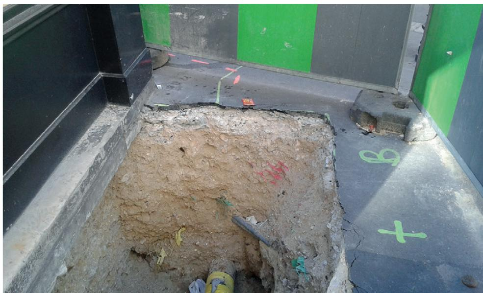
Coupe d'un trottoir asphalte : l'asphalte en surface joue le rôle de capteur de l'énergie solaire et la couche de béton, d'une dizaine de centimètres, joue le rôle de réservoir
