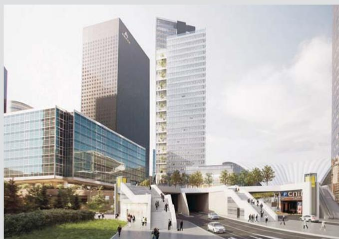
L'immeuble pont : Le projet Trinity sera implanté au-dessus de l'entrée de l'autoroute A14 et permettra de nouvelles liaisons entre le niveau bas de la rue et le niveau haut de la Dalle de La Défense.
