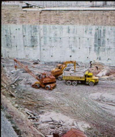
**P**our supporter la masse des 115 000 tonnes de la tour qui reposent sur une surface de base relativement faible de 2 000 m<sup>2</sup>, les fondations ont été établies avec un soin particulier. Elles s'enfoncent jusqu'au banc de craie compacte dont le toit se trouve à 62 m au-dessous du sol et s'ancrent à 6,50 m de profondeur dans cette couche résistante de terrain. Ce système d'appuis doit enjamber, grâce à des poutres de béton précontraint, le tunnel de la ligne de métro n° 6.
