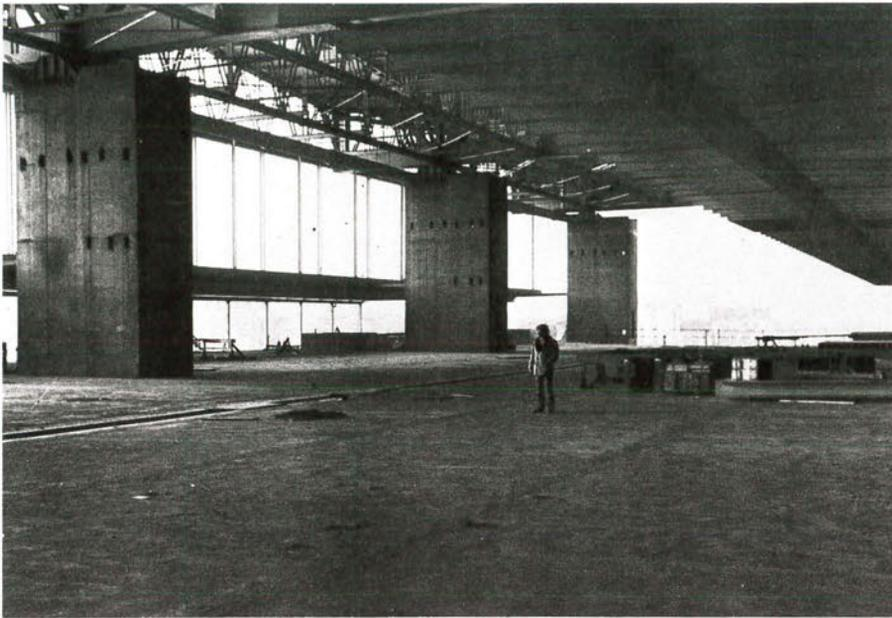
*Le niveau haut de la grande salle de vente dont la construction a été interrompue est largement dégagé (11 mètres sous toiture et 70 × 35 mètres entre les axes des tours porteuses).*
