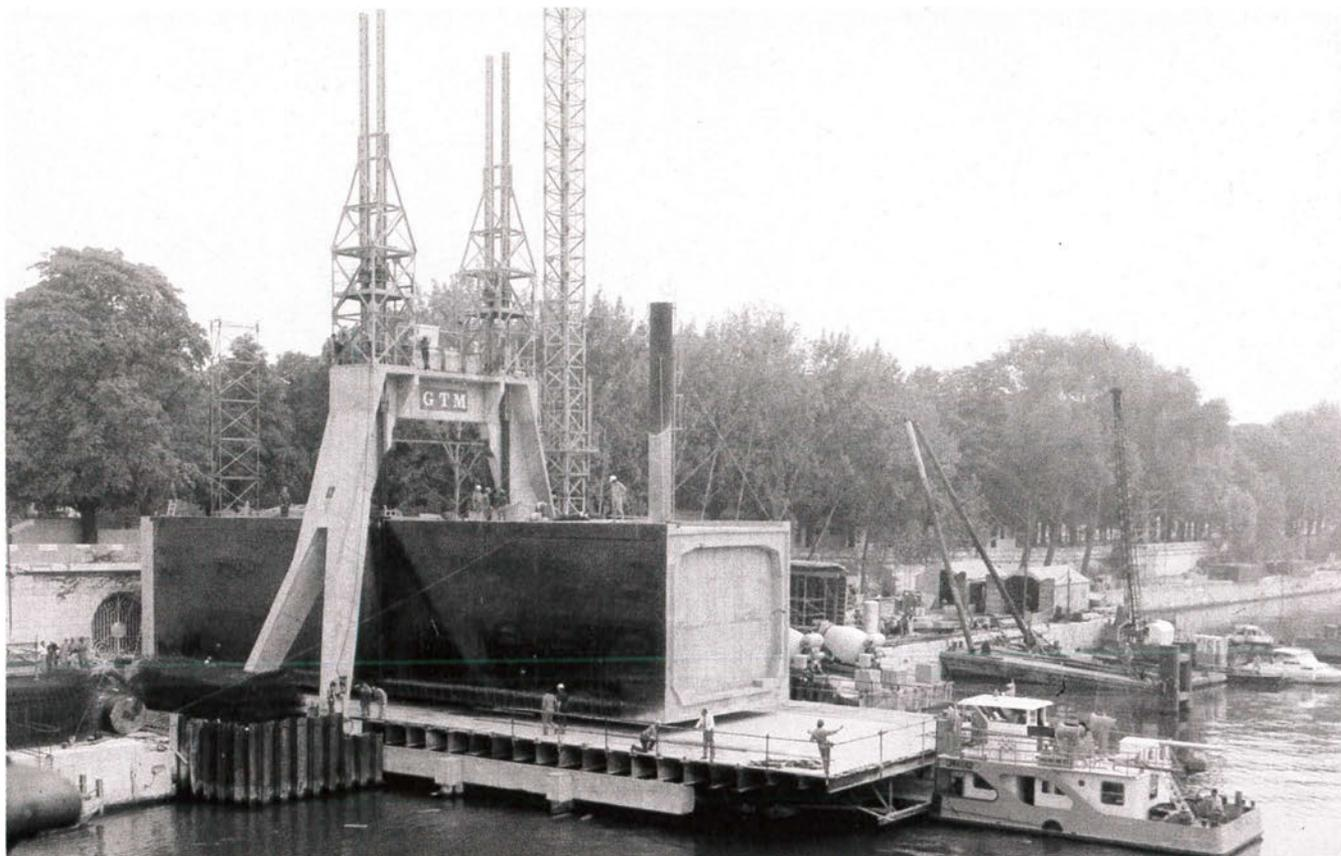
Travaux de traversée sous-fluviale pour la jonction des lignes n° 13 et 14 du métro entre les Champs Elysées et les Invalides.
