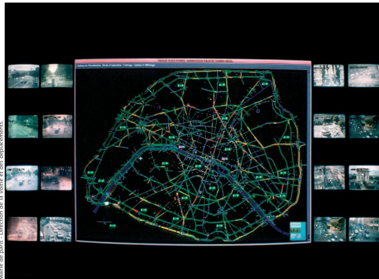
Photo : Apur. Synoptique mural du poste central d'exploitation de la circulation (PC Lutèce) Mairie de Paris - Direction de la Voirie et des Déplacements.
