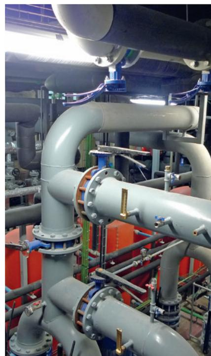
La machine à absorption permet de valoriser la fraîcheur de l'eau non potable sans tours de refroidissement.
