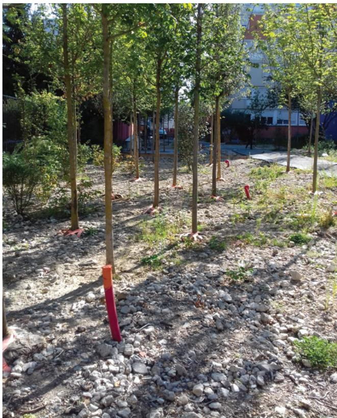
Création d'un sol non compactable à l'aide d'un mélange terre/pierre avant recouvrement par un sol en béton poreux, Aubervilliers.
