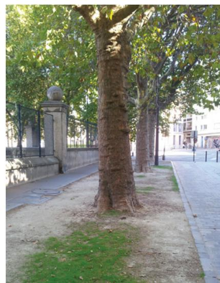
Bande perméable compactée par les piétinements : l'infiltration de l'eau n'est plus assurée.
