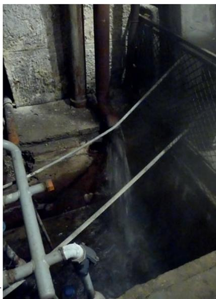
Exemple d'une sous-station mal entretenue, renvoyant les condensats directement à l'égout
