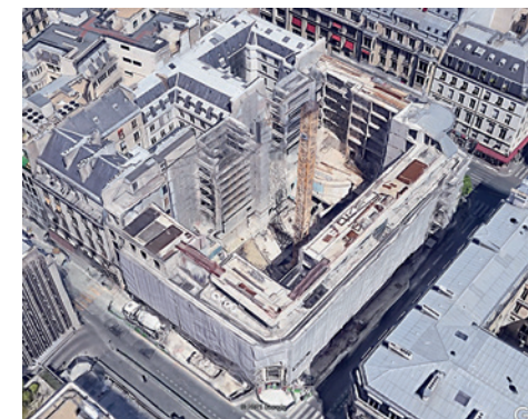
Rénovation lourde, Rue Rossini
