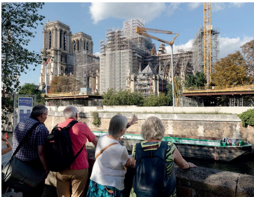
Seniors regardant le chantier de restauration de Notre-Dame
