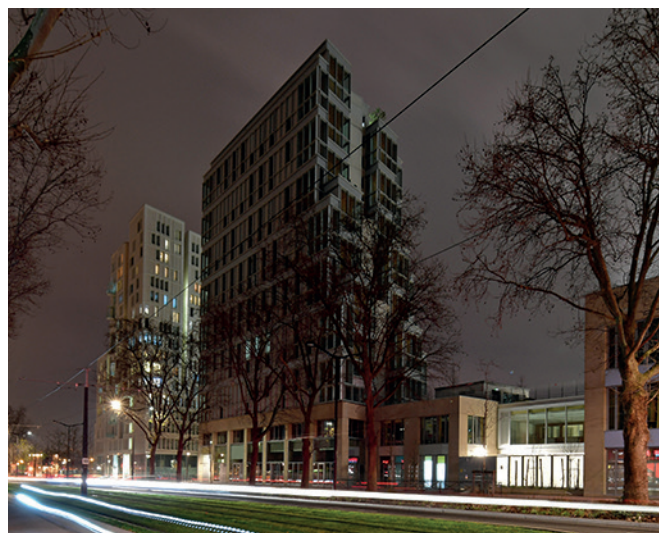
Résidence B1B3 - 23/25, boulevard du Général Jean Simon - Paris 13 e - 2021 (Architectes : Reymond Architecture & Urbanisme et Michel Guthmann & Associés (Prix Équerre d'argent 2022 catégorie « Habitat », pour la conception de cette résidence) - Maître d'ouvrage : Paris Habitat OPH)
