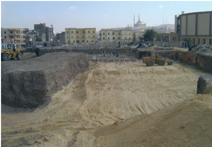
موقع العمل للمرحلة الثالثة من زينهم عند باب طولون À « Bab Tūlūn », chantier de ZeinHum 3
