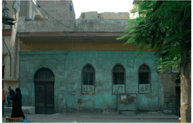
دور أرضي قديم ذو طابع رقم ٣٨ شارع طولون Rez de chaussée ancien n°38 rue Tûlûn
