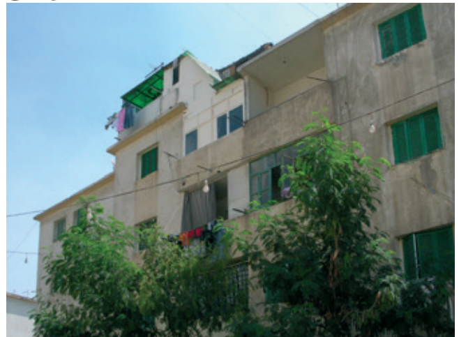
امتدادات علي الأسطح Extension en toiture
