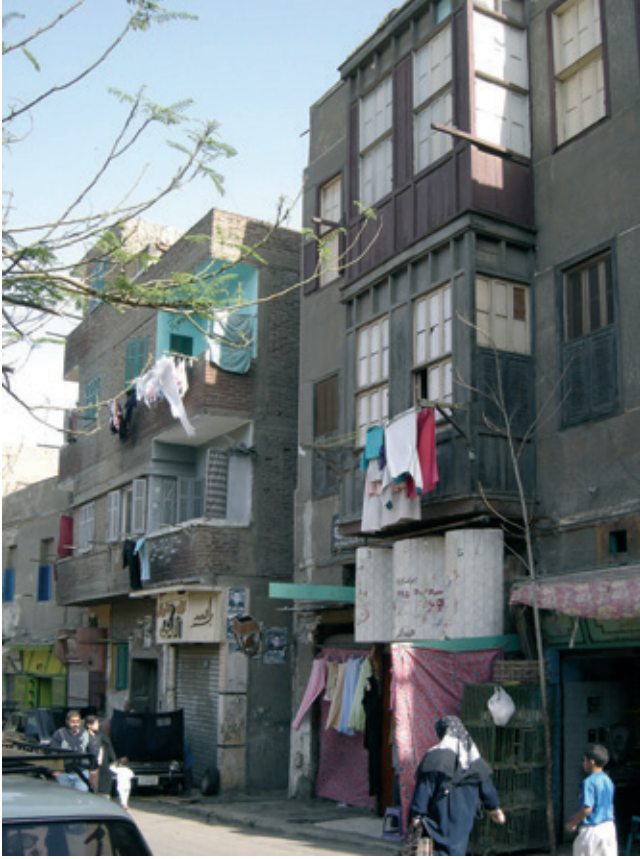
مبنى رقم ٥٥ شارع طولون Immeuble n°55 rue Tûlûn
