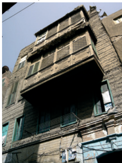
Avancée de façade en bois n°30 rue Tûlûn
