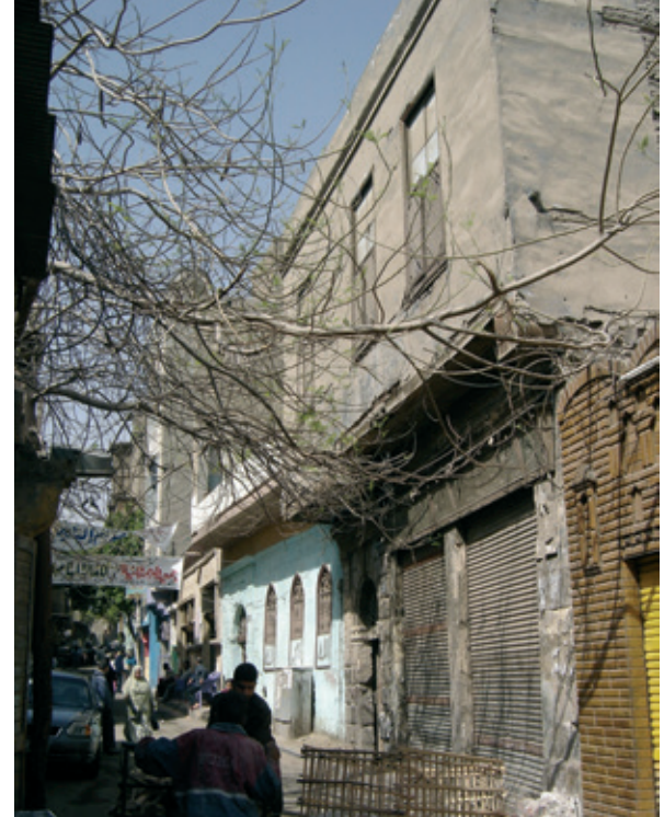
واجهة منزل من القرن الـ١٩ رقم ٤٠ شارع طولون Maison du XIX e siècle n°40 rue Tûlûn - façade
