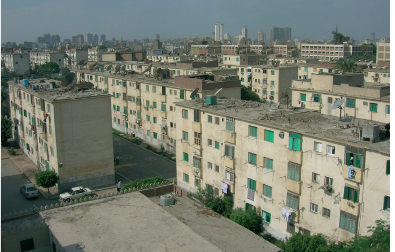
Quartier de Zeinhum - une série de bâtiments semblables زينهم - مجموعة من المباني المتشابهة
