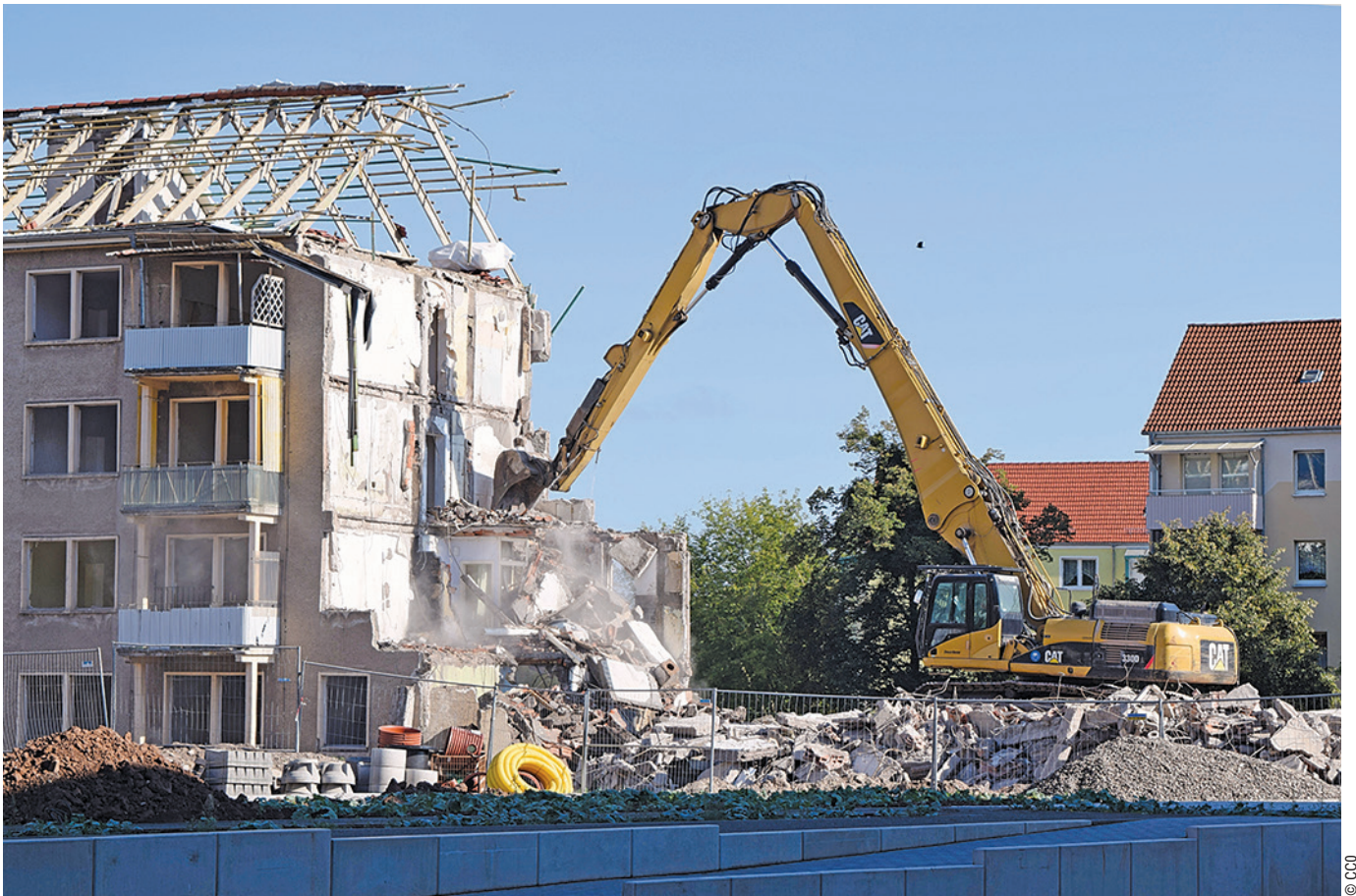
Démolition d'un immeuble d'habitation
