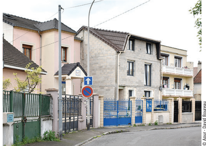
Transformation pavillonnaire, avenue de la Paix au Blanc-Mesnil (93)
