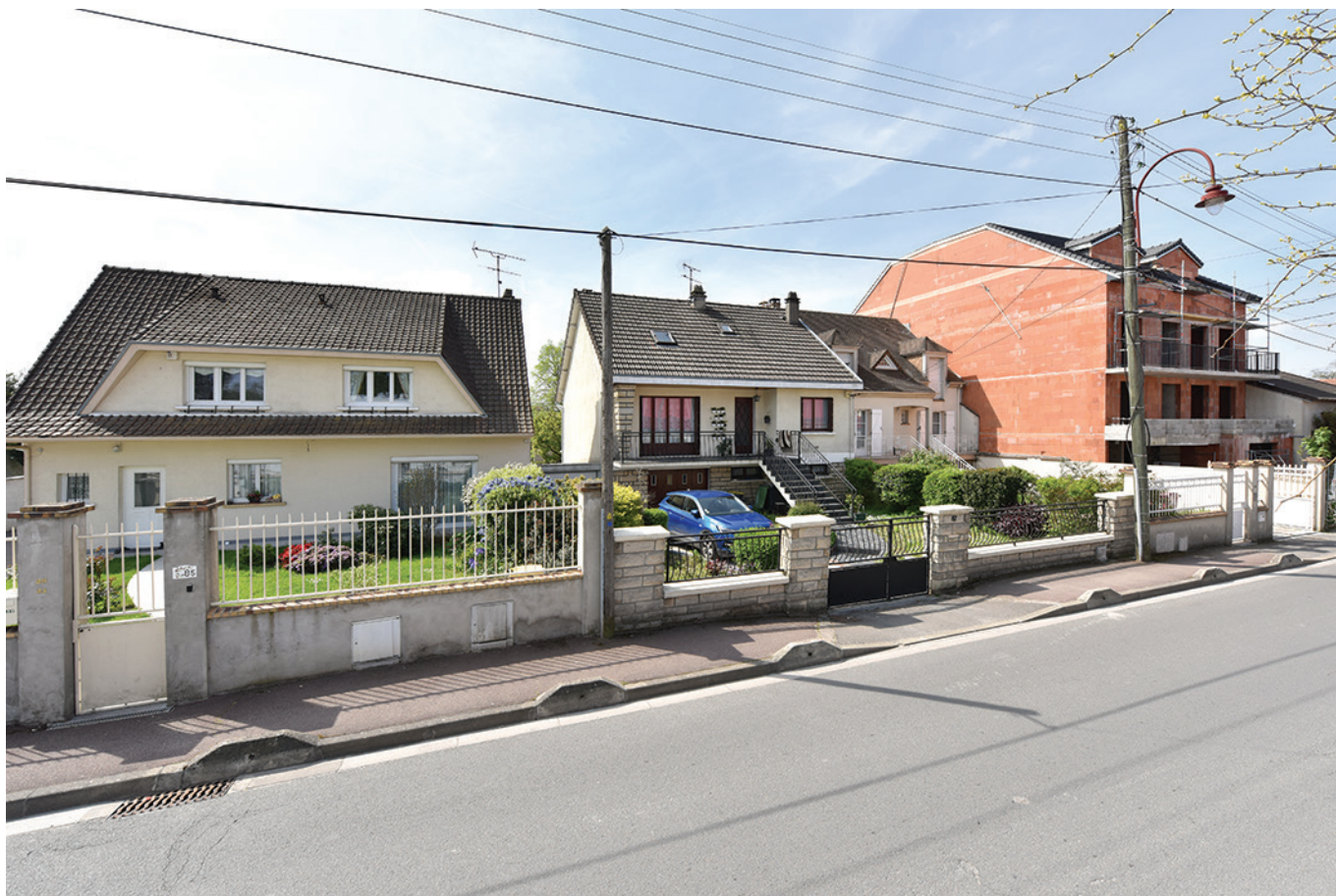
Petit immeuble en construction dans une rue pavillonnaire à Montfermeil (93)
