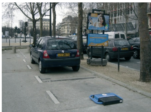
Station sur voirie réservée à un véhicule de l'opérateur Caisse Commune à Paris
