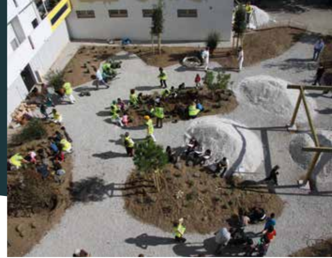
Le chantier du JardinDeMain de la cité Lemasson, à Montpellier en 2010.
