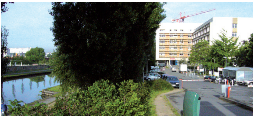
Rampe d'accès de l'hôpital Jean Verdier depuis le pont de la Forêt
