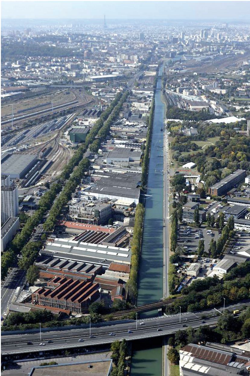
Absence d'ouvrage de franchissement entre le Pont de la Folie à Bobigny et le Viaduc de l'Autoroute A86 à Noisy-le-Sec
