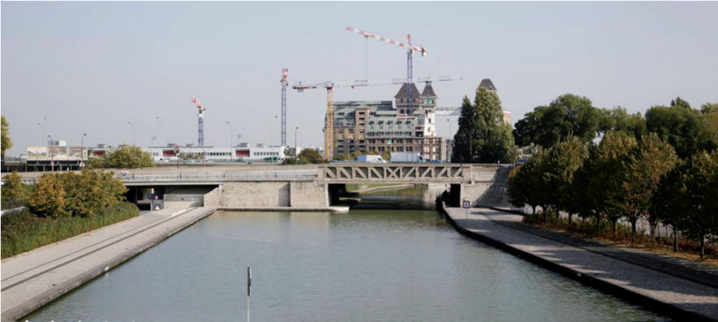
Paris : Porte de l'Ourcq : culée du pont du boulevard Mac Donald, état actuel
