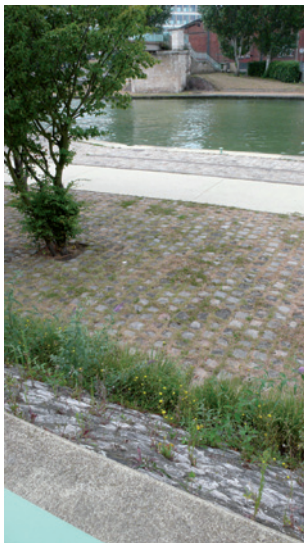
Canal Saint-Denis : aménagement récent des berges avec conservation des pavés et joints engazonnés
