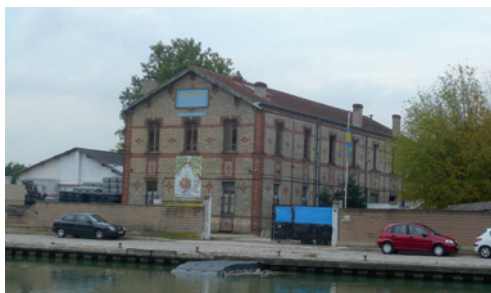
Pavillons-Sous-Bois : bâtiment de l'ancienne colonie de la Villette
