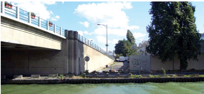
Ancienne rampe du canal depuis le Pont d'Aulnay
