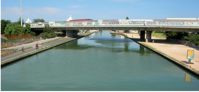
Noisy-le-Sec : viaduc de l'autoroute A3
