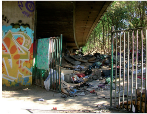
Décharge sauvage en sous-face du viaduc de l'autoroute A3
