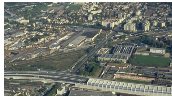
Vue aérienne, existant
