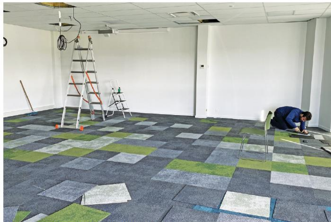
Dalles de moquette récupérées sur la plateforme Cycle up, puis reconditionnées par Orak
