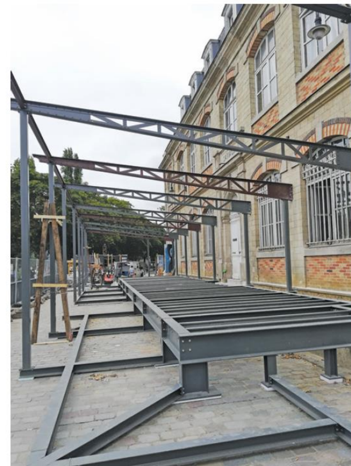
Charpente métallique pour la Maison des Canaux, Paris 19 e
