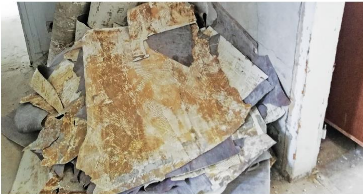
Sol en PVC déposé
