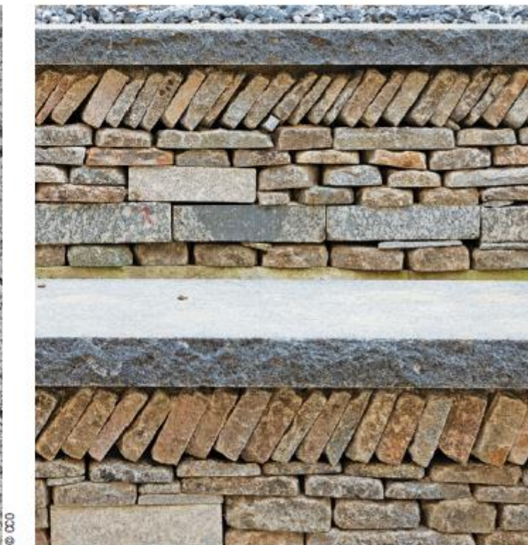
Mur réalisé en pierre réemployés, ZAC Broussais, Paris 14 e
