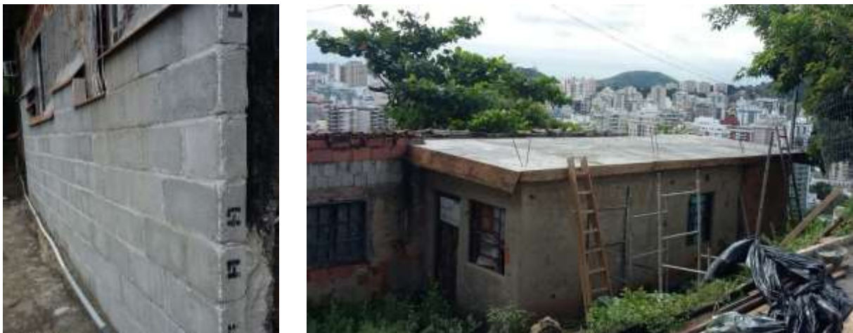
Fig. 4 : Chantiers de constructions d'un mur et d'un toit employant le béton recyclé dans la favela de Morro do Vital
