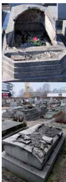
DÉTÉRIORATION DES COFFRES HAUTS EN GRANITO
