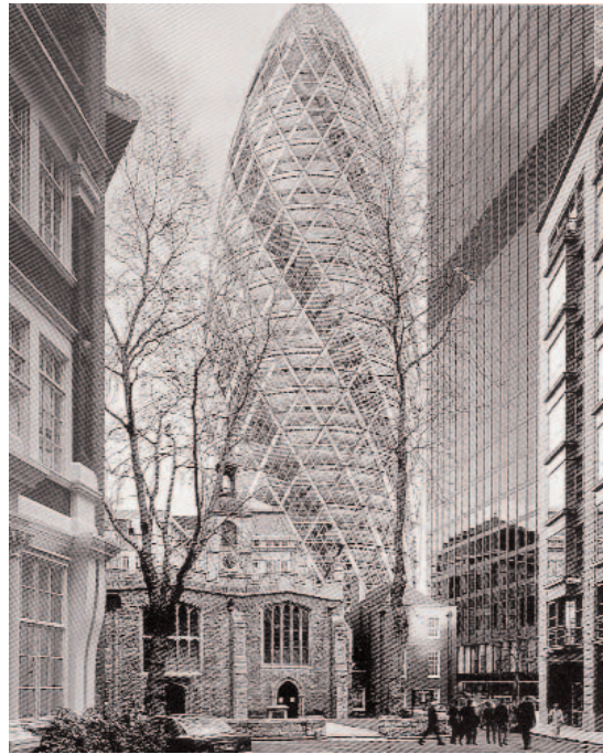
N. Foster & Partners, tour Swiss Re, Londres, à l'étude depuis 2000, perspective (source : N. Foster & Partners, Londres)
