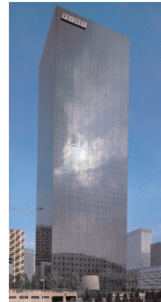
Skidmore, Owings & Merrill, R. Saubot & F. Jullien, tour Fiat (auj. Framatome) La Défense, 1974
