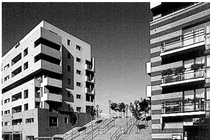
L'escalier joignant la rue de Bercy et le domaine de la SNCF, entre les immeubles des architectes Manoiesco et Beri & Gazeau.
