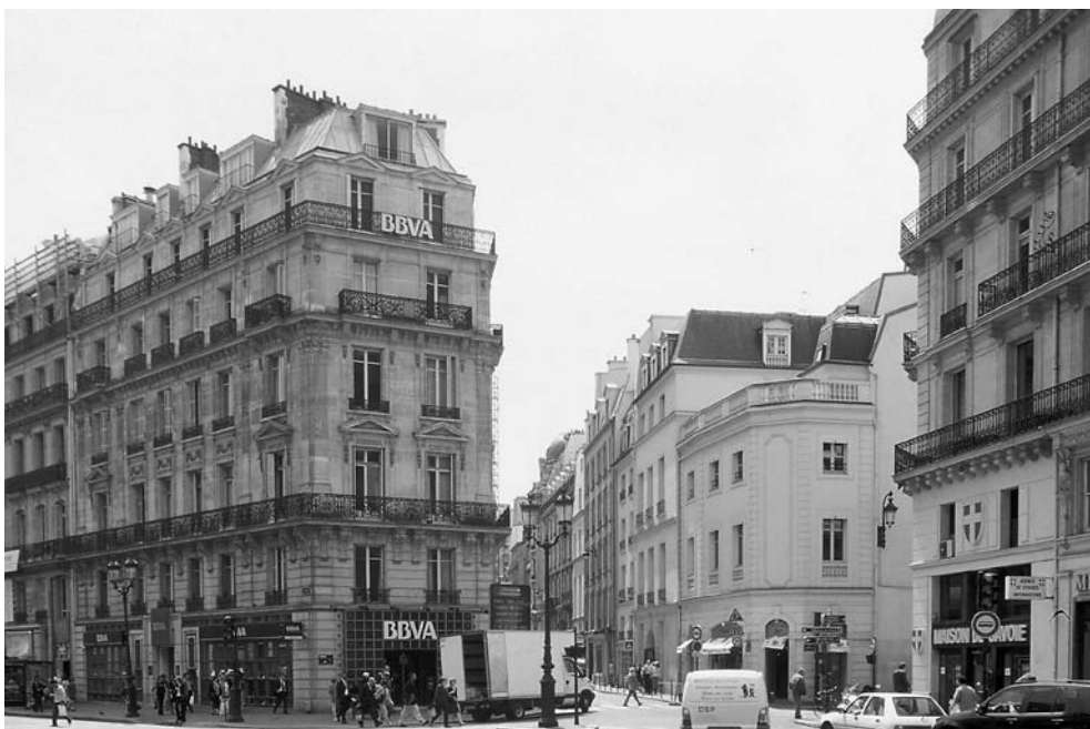
Les ordonnancements de l'avenue de l'Opéra rencontrent l'urbanisation antérieure, à l'angle des rues Saint-Roch et Gomboust.
