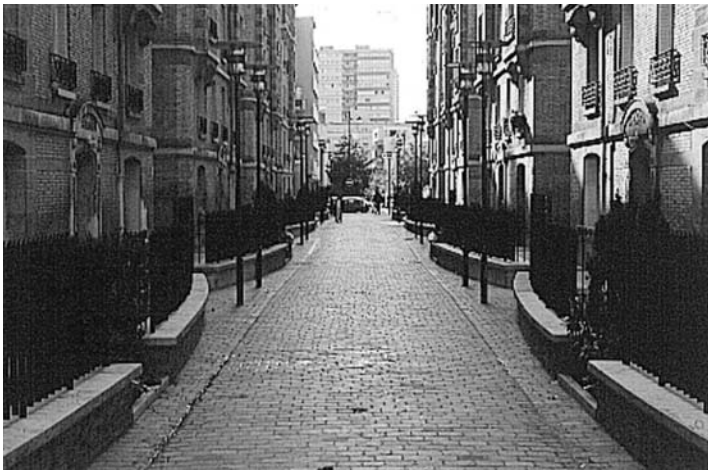
La cour de l'ensemble HBM Château-des-Rentiers, ouverte au public entre les rues Château-des-Rentiers et Albert.
