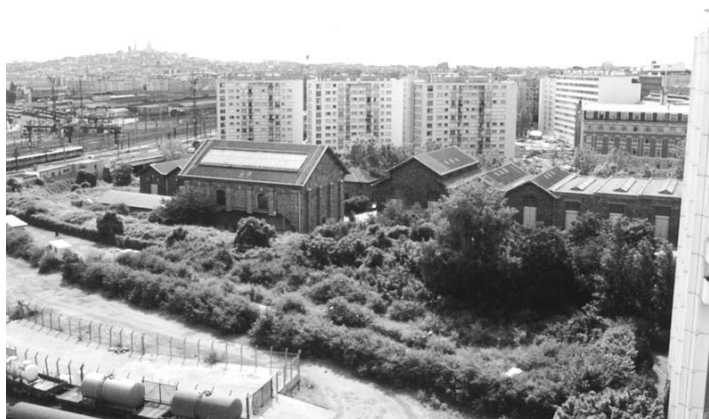
Vue du bastion n° 45, enfoui sous la végétation.
