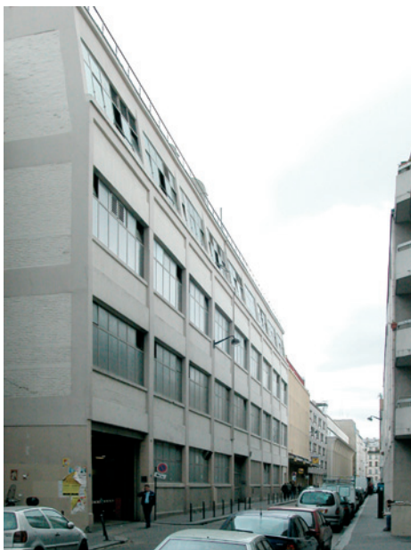
Bâtiment A «Garage»
