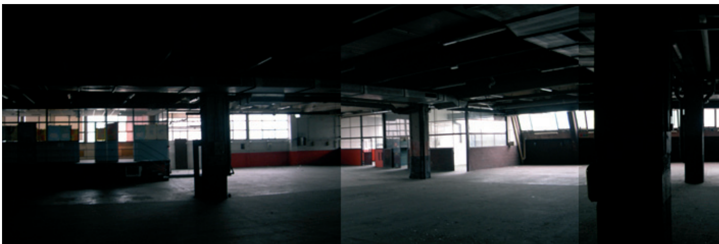
Le garage de La Poste, 17-19 rue Bréguet, vues intérieures
