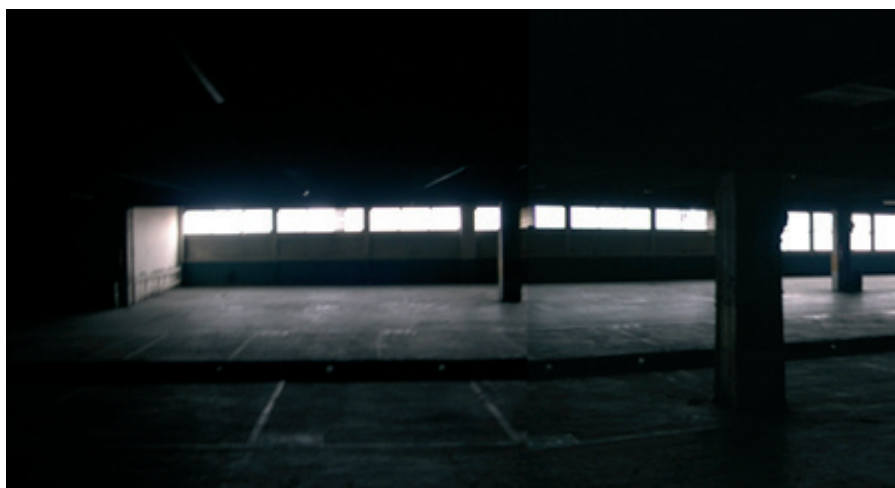
Un étage courant du garage
