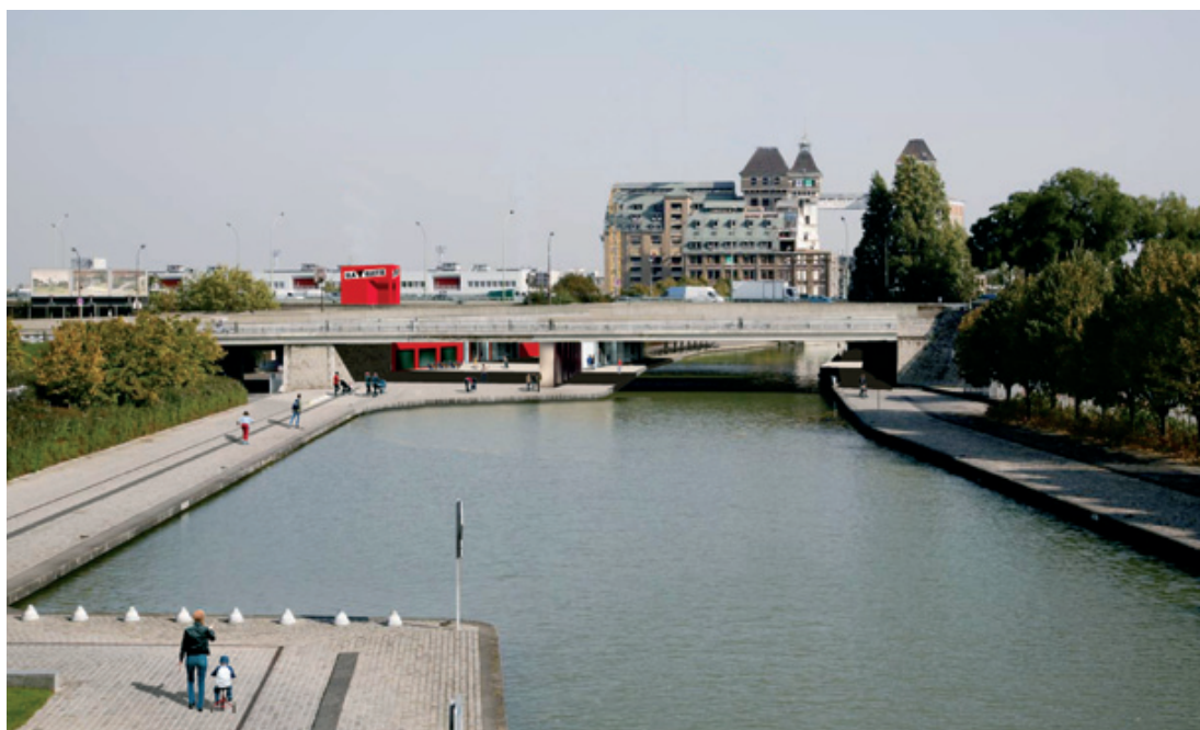
Le pont du boulevard des maréchaux allongé
