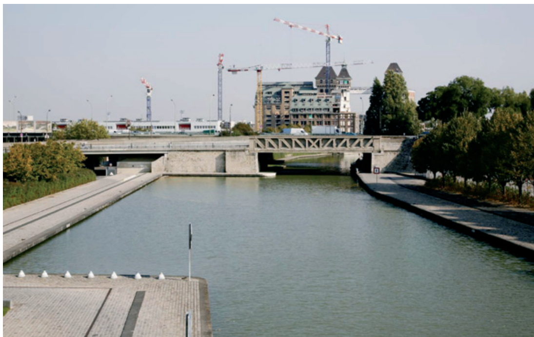
Le pont du boulevard des maréchaux vue depuis La Villette
