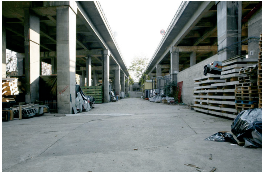
L'espace entre les piles du périphérique avant et après
