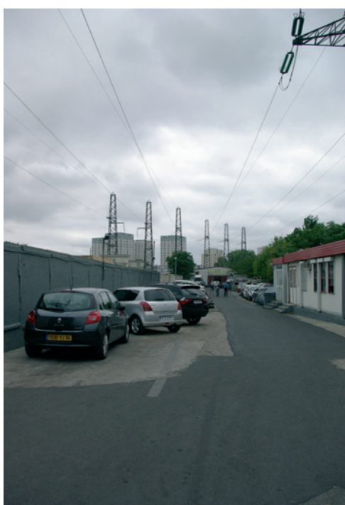
Lignes à hautes tensions le long de l'ex RN7
