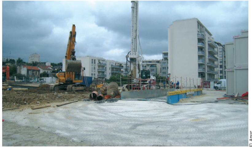
Aménagement de la ZAC Guippons-Pasteur sur l'ex RN7 à Villejuif
