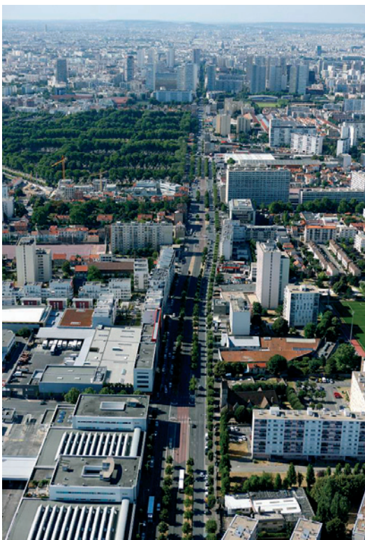
Aménagement du site propre bus, vue vers la porte de Choisy
