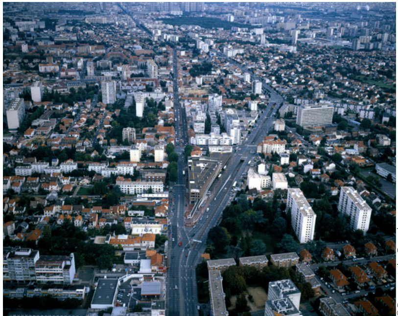
Parking d'intérêt général de Villejuif
