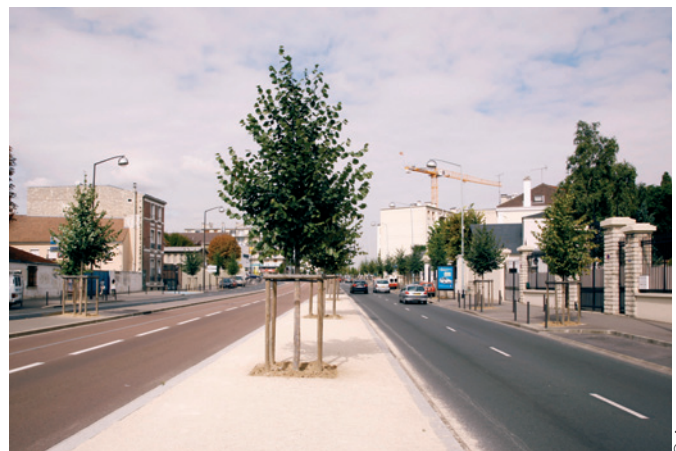
Aménagements du bus en site propre à Vitry-sur-Seine, en 2008
