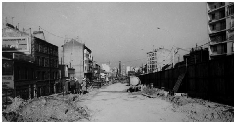
Chantier de construction du métro, RN7, années 1980
