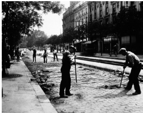
Arrachage du vieux pavage, 1926
