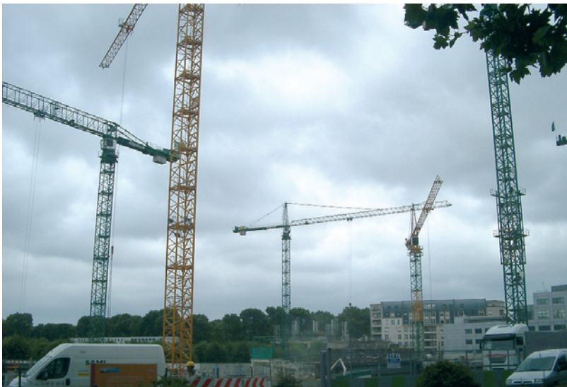
Aménagement de la ZAC de Fontainebleau au Kremlin-Bicêtre
