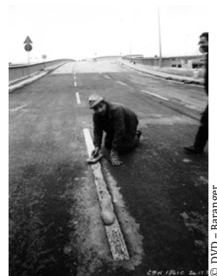
Nouveau revêtement de voirie
