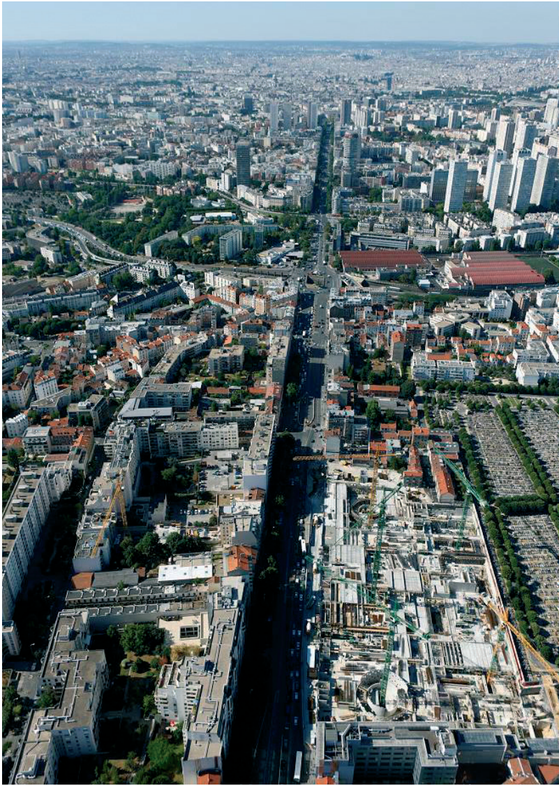
Construction d'un centre commercial aux abords de la Porte d'Italie
