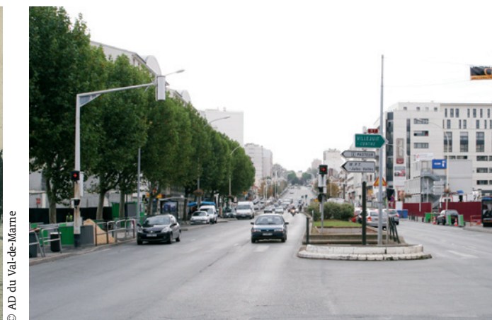
Alignement d'arbres à Villejuif, en 2008
