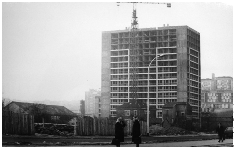
Construction de grands ensembles au cœur de Vitry-sur-Seine
