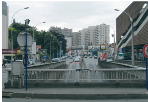
Passage souterrain à gabarit réduit face à la gare routière
