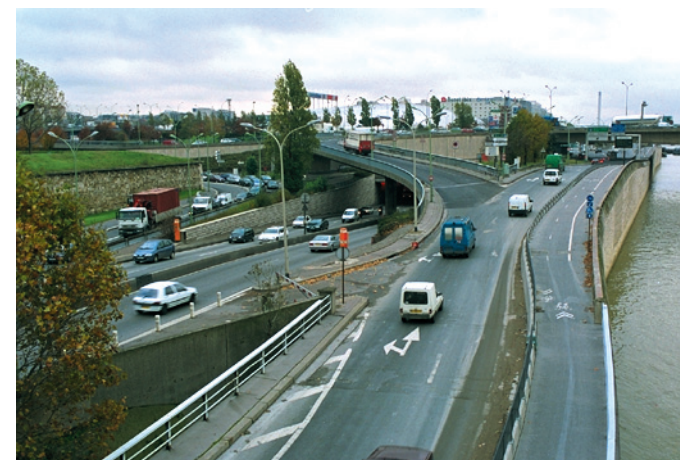
Quai de Bercy (Paris 12 e ), aval du pont National, vue vers l'amont. Piste cyclable et piétonne en estacade le long du quai. Bretelles de l'échangeur de Bercy.
