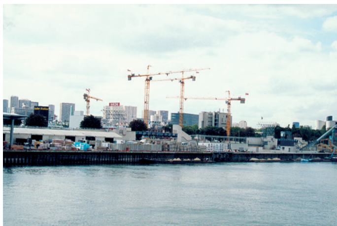
Port d'Ivry (Ivry-sur-Seine), partie aval du port. Vue depuis la rive droite. Installations industrielles. Promenade haute en arrière plan.
