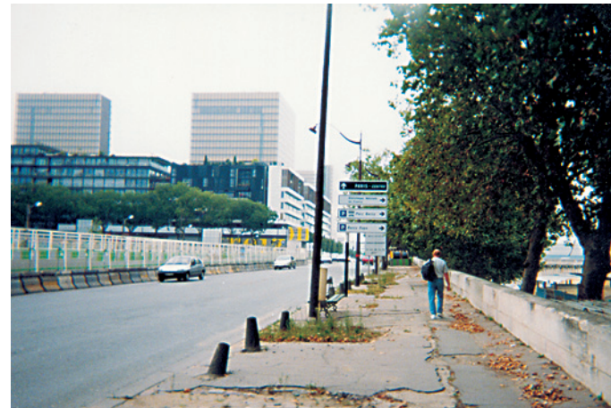
Quai Panhard et Levassor (Paris 13 e ), amont du pont de Tolbiac, vue vers l'aval. Travaux de la ZAC Paris Rive Gauche côté bâti.
