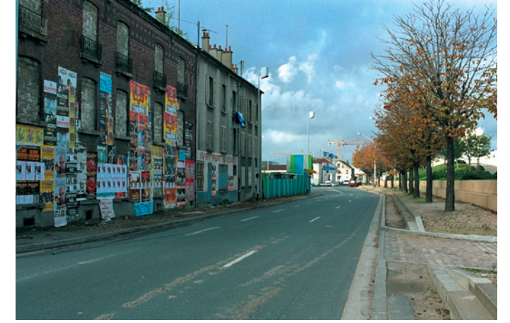
Quai J. Compagnon (Ivry-sur-Seine), vue vers l'aval. Trottoirs étroits ; double trottoir côté Seine.
