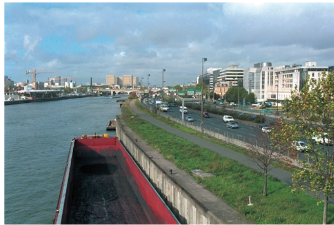
Vue vers l'aval depuis le pont Nelson Mandela Aval (Charenton-Le-Pont). Absence de berge. Quai de Charenton et autoroute A4.
