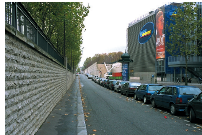
Quai de Bercy (Paris 12 e ), amont du parc de Bercy, côté bâti, vue vers l'aval. Multiplex ; accès à la terrasse du parc de Bercy.
