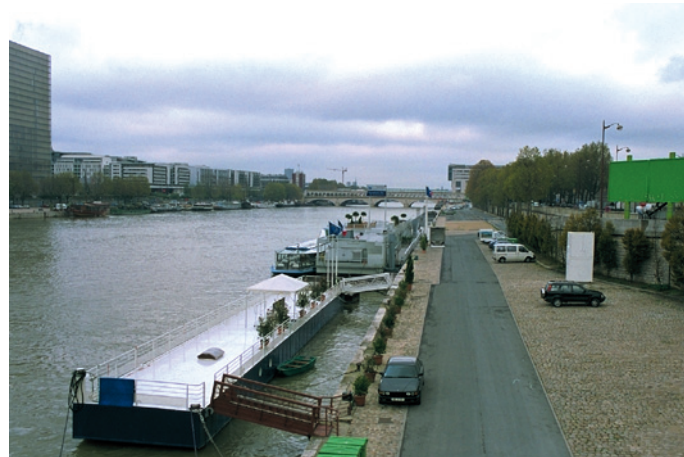
Port de Bercy aval (Paris 12 e ), vue vers l'aval depuis le pont de Tolbiac. Réaménagement récent du port.
