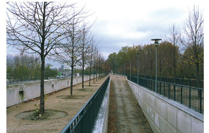
Accès à la terrasse du parc de Bercy (Paris 12 e ), vue vers l'aval.
