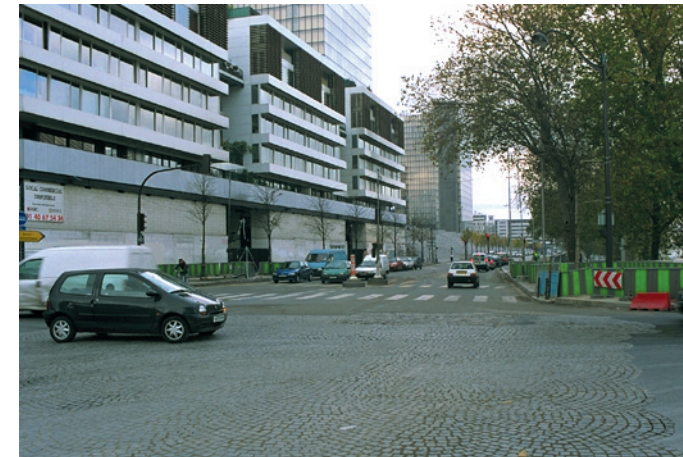
Quai François Mauriac (Paris 13 e ), tête du pont de Tolbiac. Vue vers l'aval.
