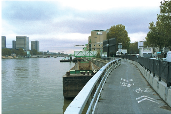
Piste cyclable en estacade le long du quai (Paris 12 e ), aval du pont National, vue vers l'aval. Rétrécissement de la piste (vélos et piétons non séparés).
