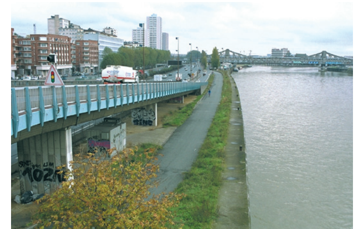
Rampe d'accès du pont Nelson Mandela amont, vue vers l'amont depuis le pont. Quai de Charenton longeant la Seine (Charenton-Le-Pont).
