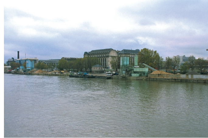
Vue du port de Tolbiac (Paris 13 e ) depuis la rive droite.
