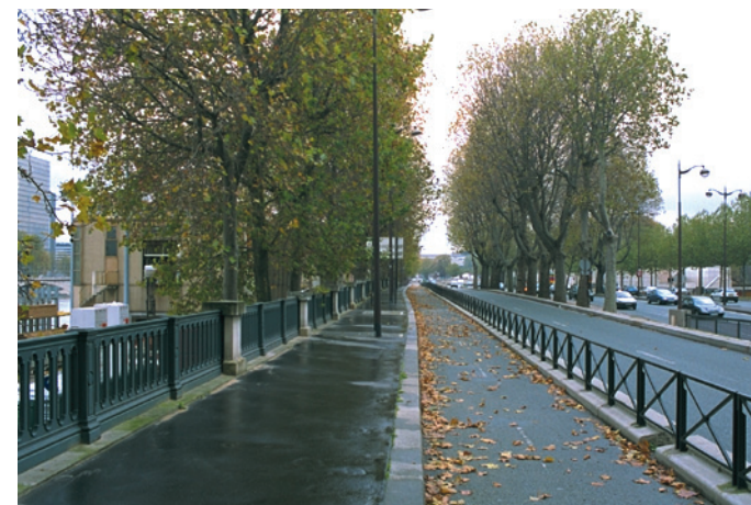
Quai de Bercy (Paris 12 e ) au niveau du parc de Bercy, côté Seine, vue vers l'aval. Trottoir et piste cyclable bidirectionnelle, séparateur haut.
