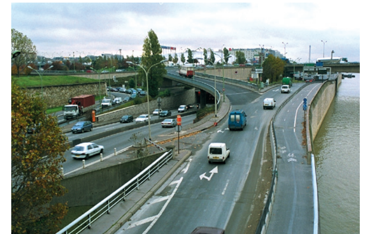
Aval du boulevard périphérique (Paris 12 e ), vue vers l'amont, berges interrompues ; piste cyclable en estacade au premier plan, prolongeant le quai de Charenton.
