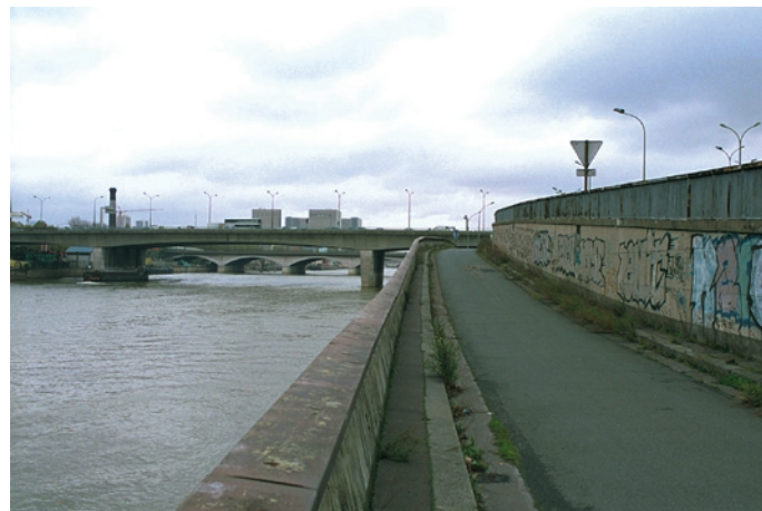
Quai de Charenton (Charenton-Le-Pont), vue vers l'aval. Amont de la limite administrative avec Paris.
