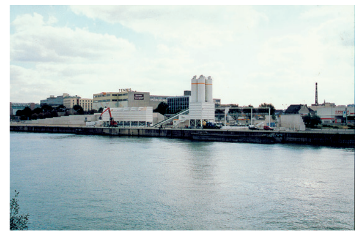
Port d'Ivry (Ivry-sur-Seine), vue depuis la rive droite. Installations industrielles ; longées par la promenade au second plan.
