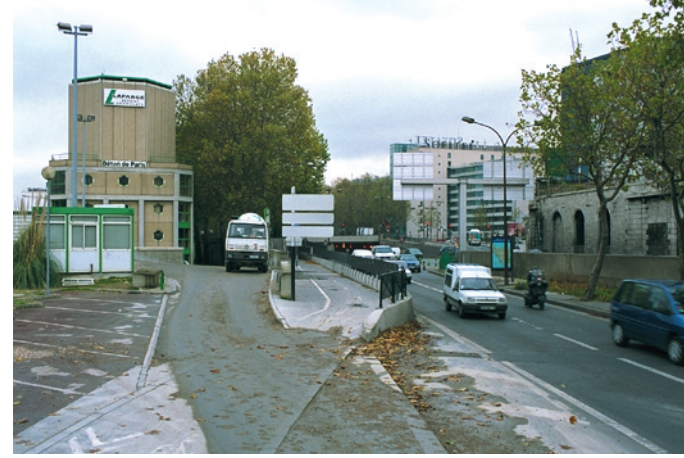
Sortie de port de Bercy amont (Paris 12 e ), reprise des berges, vue vers l'aval.
