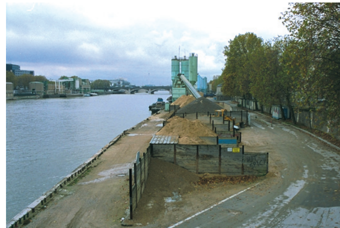
Port de Tolbiac (Paris 13 e ). Installations industrielles et stockage de matériaux. Vue vers l'amont. Espace non construit en bord de Seine utilisé par les engins de manutention.
