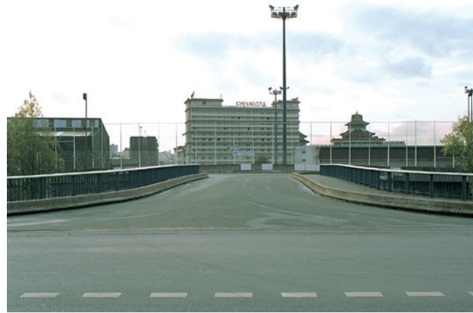
Pont Martinet, enjambant l'autoroute A4 (Charenton) et reliant le quai des Carrières au quai de Charenton, au niveau du stade H. Guérin. Vue depuis le quai des Carrières.
