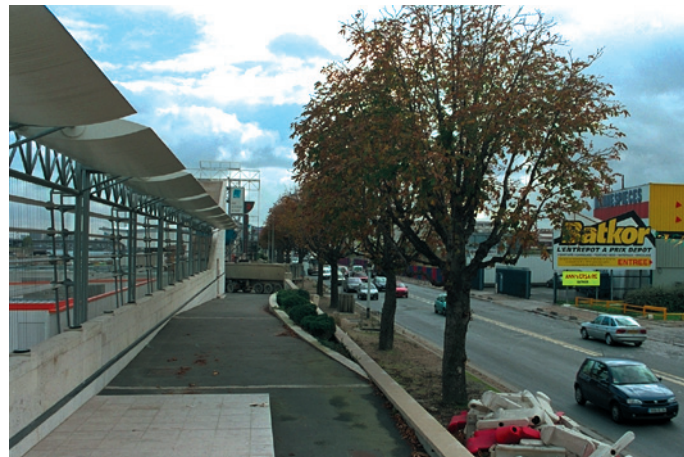
Quai Marcel Boyer (Ivry-sur-Seine). Promenade rehaussée par rapport au trottoir. Vue vers l'amont.
