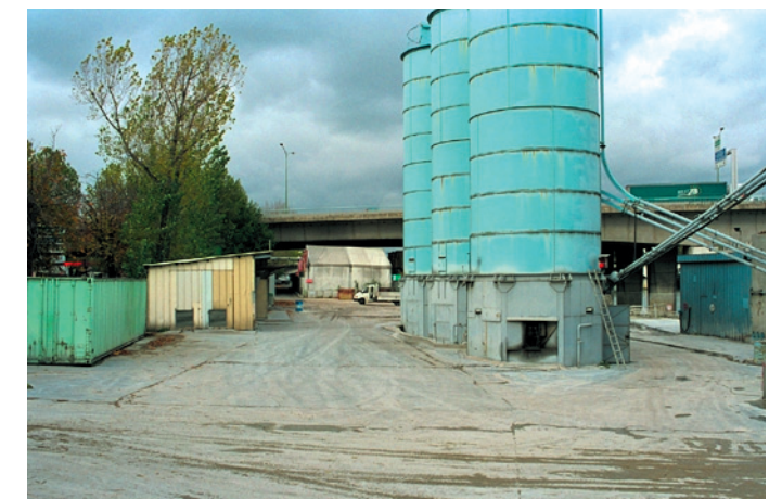
Port d'Ivry (Ivry-sur-Seine), amont du boulevard périphérique, installations industrielles, vue vers l'aval.
