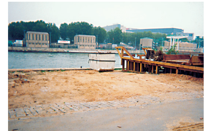
Port de Tolbiac (Paris 13 e ), espace libre entre des installations industrielles. Voie de circulation dégradée. Installations industrielles du port de Bercy en arrière-plan.
