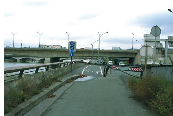
Fin du quai de Charenton (Charenton-Le-pont), limite administrative avec Paris, vue vers l'aval. Barrière d'accès amovible.
