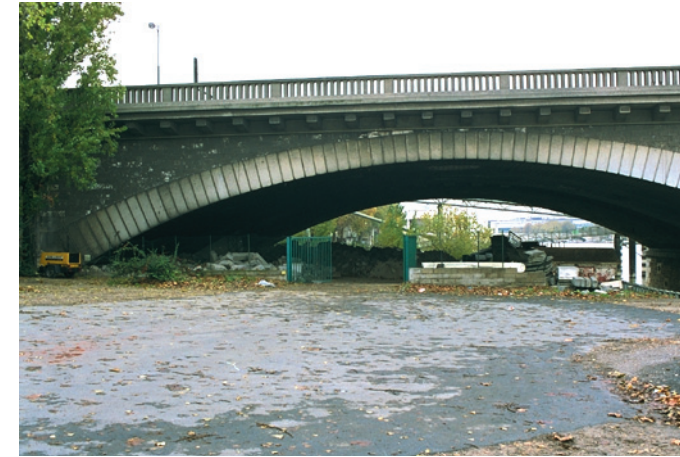
Port National (Paris 13 e ), amont du pont National. Barrière et stockage sous le pont. Vue vers l'aval.
