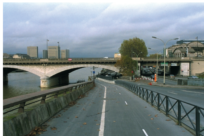
Piste cyclable et piétonne le long du quai (Paris 12 e ), amont du pont National, vue vers l'aval.
