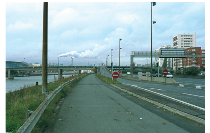
Quai de Charenton longeant la Seine et utilisé comme piste cyclable (Charenton-Le-Pont), amont des ponts Nelson Mandela, vue vers l'aval. Accès à l'autoroute.
