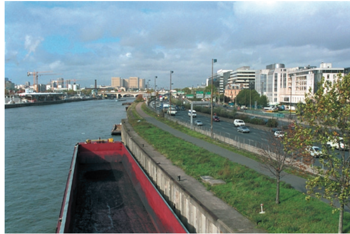
Vue de la rive droite depuis le pont Nelson Mandela aval (Charenton-Le-Pont), vue vers l'aval. Absence de berge. Quai de Charenton utilisé comme piste cyclable et autoroute A4 longeant la Seine.
