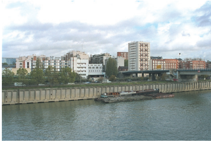
Vue de la rive droite au niveau du pont Nelson Mandela amont (Charenton-Le-Pont) depuis la rive gauche. Absence de berge.
