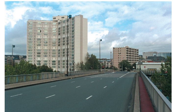
Sur le pont Mandela aval (Charenton-Le-Pont), vue vers Charenton centre. Circulations douces difficiles, absence de trottoir.
