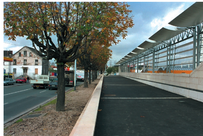
Port d'Ivry (Ivry-sur-Seine), séquence basse de la promenade, le long du trottoir. Vue vers l'aval.
