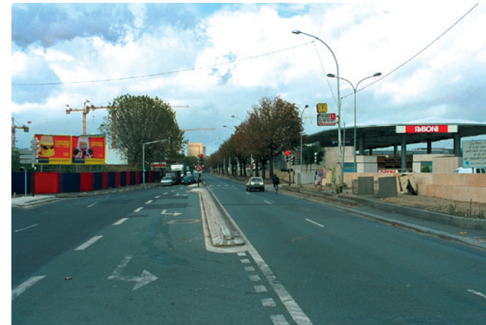
Quai Marcel Boyer (Ivry-sur-Seine). Chantier de la ZAC Port d'Ivry côté bâti. Vue vers l'aval.
