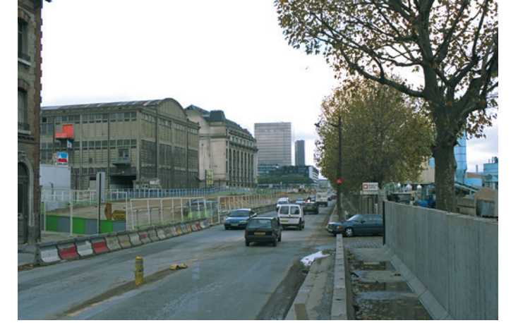
Quai Panhard et Levassor (Paris 13 e ), aval du pont National, vue vers l'aval.
