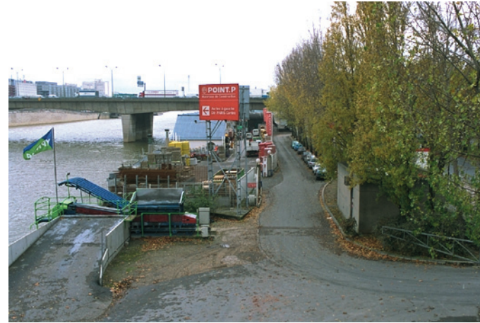
Port National (Paris 13 e ), aval du boulevard périphérique. Vue vers l'amont depuis le pont National.
