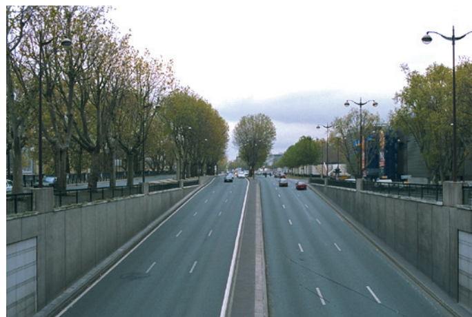
Quai de Bercy (Paris 12 e ), passage souterrain sous le carrefour quai de Bercy / avenue des Terroirs de France, vue vers l'aval.
