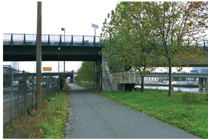
Pont Nelson Mandela aval (Charenton-Le-Pont). Escalier d'accès au pont, vue vers l'amont.
