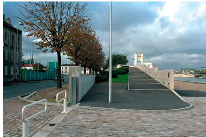
Port d'Ivry (Ivry-sur-Seine), accès amont à la promenade haute. Rampe avec pas-de-mule. Vue vers l'aval.
