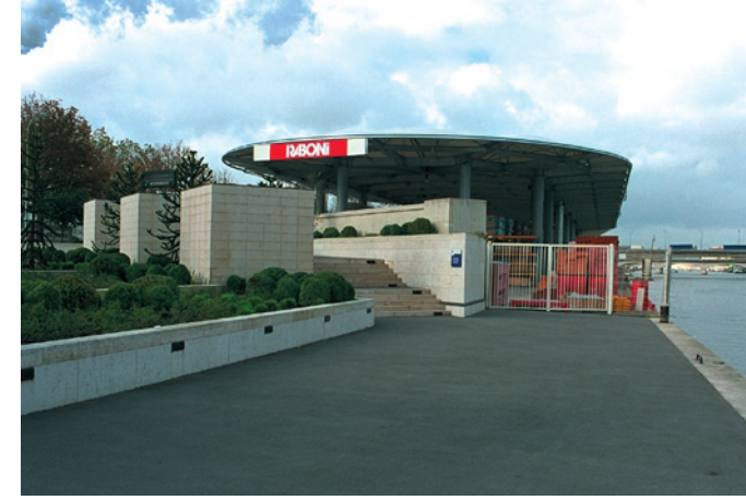
Port d'Ivry (Ivry-sur-Seine), accès piéton au bord de l'eau. Vue vers l'aval.
