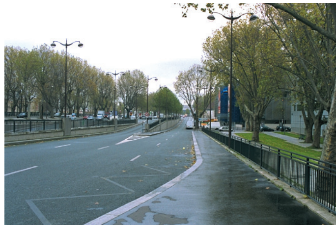
Quai de Bercy (Paris 12 e ), aval de l'avenue des Terroirs de France, côté bâti, vue vers l'aval.
