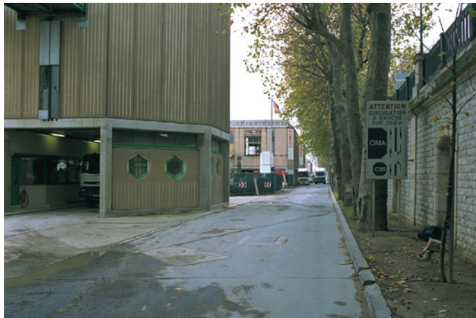
Port de Bercy amont (Paris 12 e ), vue vers l'aval. Voie de circulation dans le port entre le mur du quai haut et la centrale à béton.
