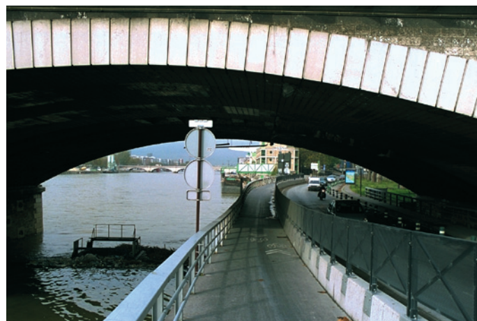
Piste cyclable et piétonne en estacade le long du quai (Paris 12 e ), passage sous le pont National, vue vers l'aval. Rétrécissement de la piste (vélos et piétons non séparés).
