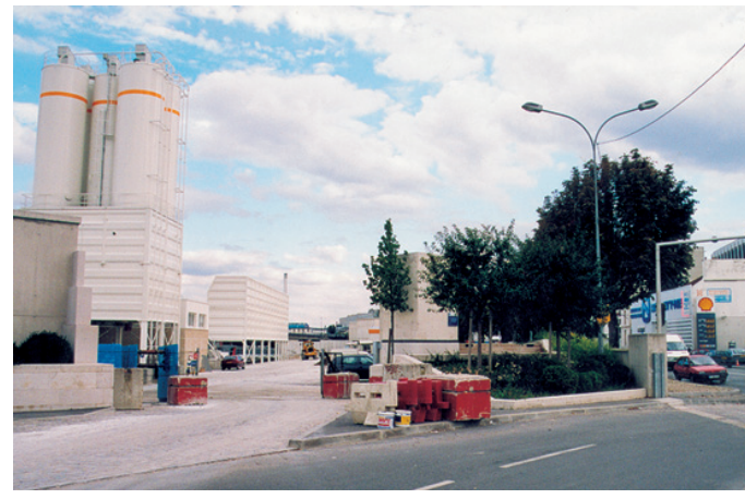
Accès au Port d'Ivry (Ivry-sur-Seine). Fin de la séquence haute de la promenade. Accès piéton au bord du fleuve.
