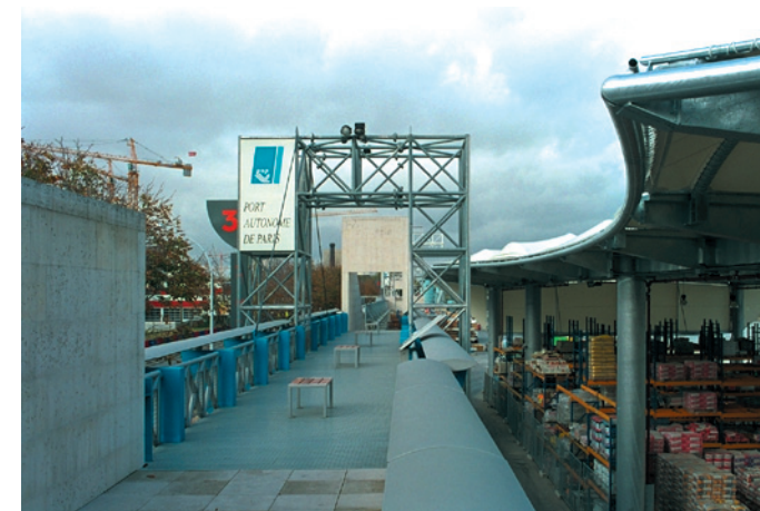
Port d'Ivry (Ivry-sur-Seine), au niveau de la TIRU. Promenade haute. Vue vers l'aval.
