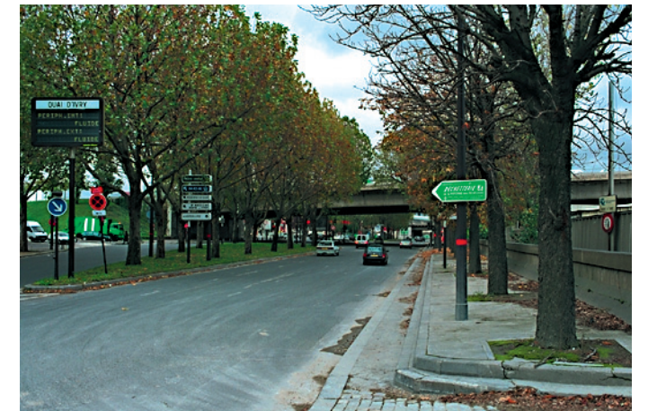
Quai d'Ivry (Paris 13 e ). Amont du boulevard périphérique. Limite communale entre Ivry et Paris. Vue vers l'aval. Double trottoir planté en bon état à Paris.
