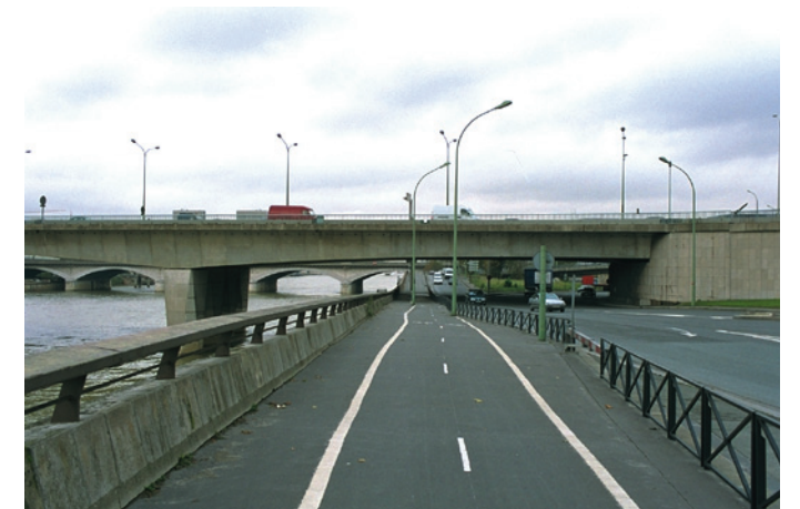
Piste cyclable et piétonne (Paris 12 e ) en prolongement du quai de Charenton et passant sous le boulevard périphérique, vue vers l'aval.
