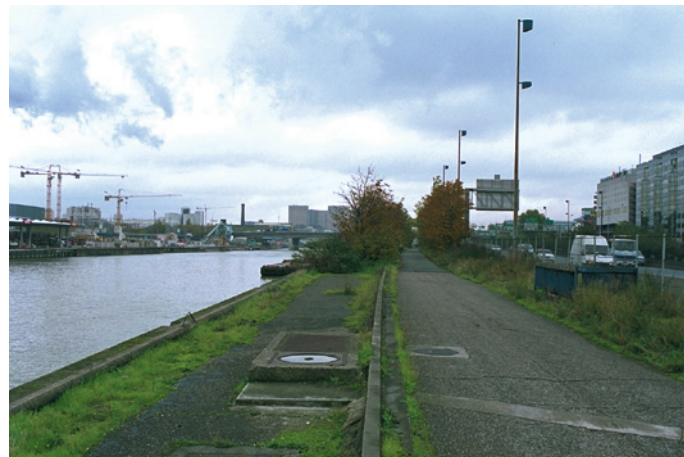
Quai de Charenton, aval des ponts Nelson Mandela (Charenton-Le-Pont), absence de berge basse. Vue vers l'aval. Problème d'entretien de la voie.
