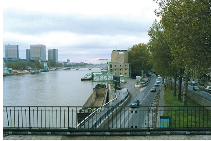
Sortie du port de Bercy amont (Paris 12 e ), reprise des berges, vue vers l'aval depuis le pont National.
