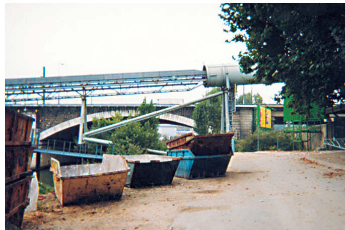
Port de Tolbiac (Paris 13 e ), aval du pont National. Tapis roulant d'acheminement des déblais de chantier. Vue vers l'amont. Berge non maçonnée au 2 nd plan.
