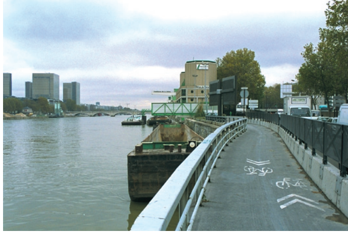
Aval du pont National (Paris 12 e ), vue vers l'aval, absence de berge, piste cyclable en estacade.
