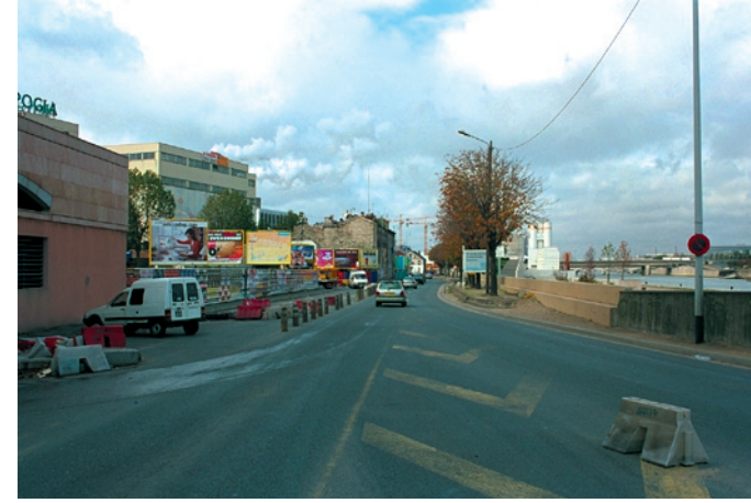
Quai J. Compagnon (Ivry-sur-Seine), Vue vers l'aval.
