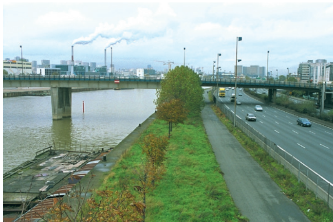
Quai de Charenton et autoroute A4 (Charenton-Le-Pont), vue vers l'aval depuis le pont Nelson Mandela amont. Absence de berge basse.
