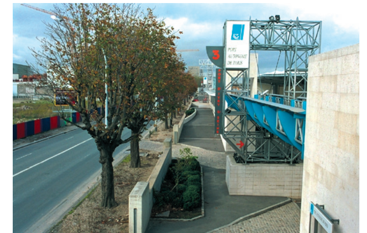
Port d'Ivry (Ivry-sur-Seine), promenade haute. Pas d'accès cycliste. Vue vers l'aval.
