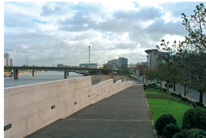
Port d'Ivry (Ivry-sur-Seine), accès amont à la promenade haute, vue vers l'amont depuis la promenade haute.
