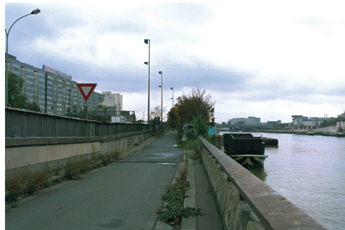
Quai de Charenton utilisé comme piste cyclable (Charenton-Le-Pont), vue vers l'amont. Amont de la limite administrative avec Paris.
