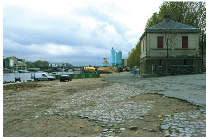
Port de Tolbiac (Paris 13 e ). Accès au port. Vue vers l'amont. Revêtement dégradé. Bâtiment R+1 sur la berge au bord du quai.
