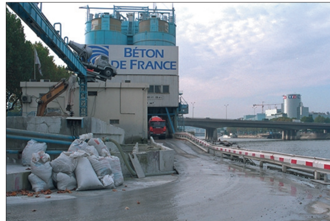
Port Victor (Paris 15 e ), centrale à béton en bord de quai.
