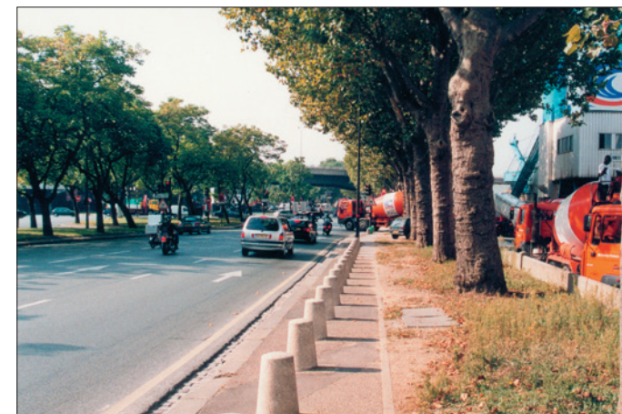
Quai d'Issy-Les-Moulineaux (Paris 15 e ), en amont du bd périphérique. Vue vers l'aval. Borne de défense sur le trottoir. Sortie de camions du port industriel.
