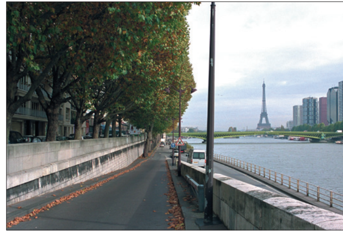
Quai Louis Blériot (Paris 16 e ) vers l'amont (pont Mirabeau). Bretelle d'accès à la voie G. Pompidou sur berge.
