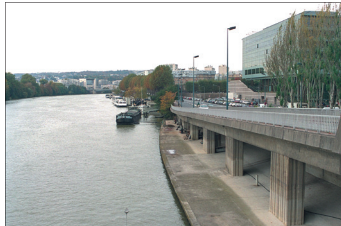
Berge à Boulogne-Billancourt. Occupation précaire sous la rampe aval du pont d'Issy. Vue vers l'aval.
