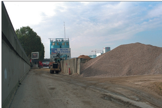
Port Victor (Paris 15 e ) vue vers l'aval le long de la rampe d'accès au port.
