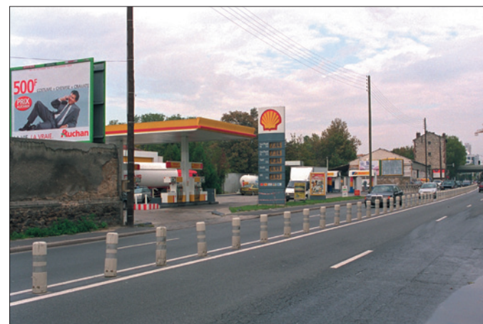
Quai de Stalingrad (Issy-Les-Moulineaux), en amont du pont de Billancourt. Vue vers l'amont. Installation entre le quai et la berge.
