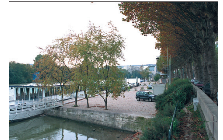
Port large à Boulogne-Billancourt. Détail de l'aménagement du port. Vue vers l'aval.
