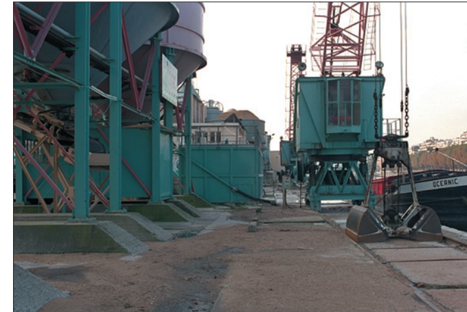
Installation industrielle en bord de quai, port de Javel Bas en aval du pont Mirabeau, vue vers l'aval.
