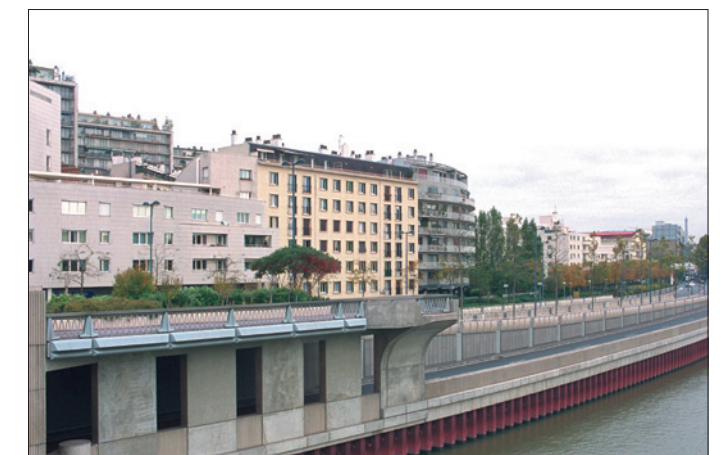
Occupation des berges par la circulation en amont du pont de Billancourt (Boulogne-Billancourt). Vue vers l'amont.
