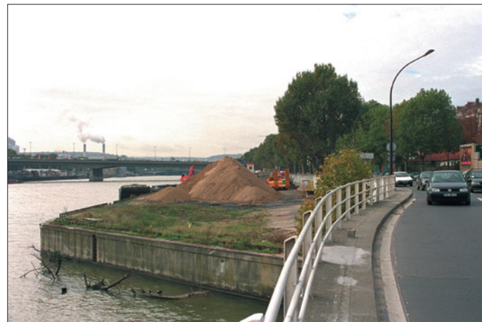
Extrémité du port du Point du Jour (Paris 16 e ). Vue vers l'aval, depuis l'accès à la voie sur berge. Interruption de la berge.
