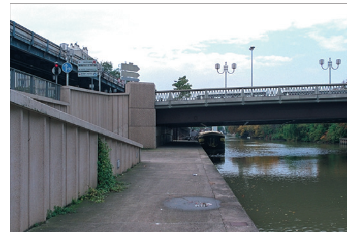
Bras d'Issy-Les-Moulineaux en amont du pont de Billancourt, rampe d'accès au quai, vue vers l'aval.
