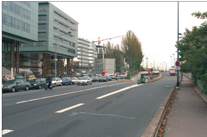
Quai du Point du Jour - RD1, vers l'amont. Passage routier dénivelé à l'aval de la tête du pont d'Issy.
