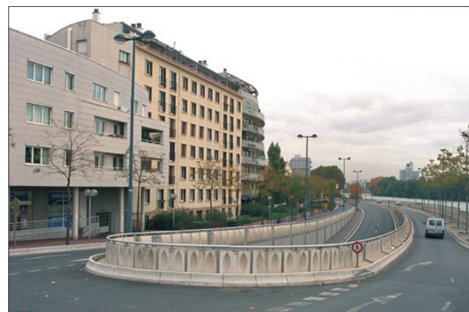
Vue vers l'amont. Passage dénivelé en amont de la tête du pont de Billancourt (Boulogne-Billancourt).
