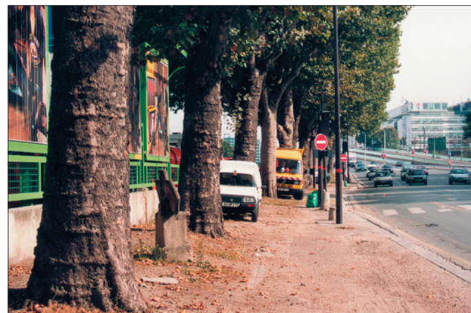
Quai d'Issy-Les-Moulineaux (Paris 15 e ), en amont du bd périphérique. Vue vers l'amont. Trottoir dégradé et stationnement illicite.
