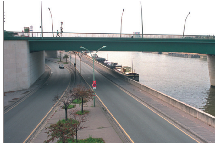
Quai André Citroën (Paris 15 e ) sous le pont Garigliano. Vue vers l'aval (Issy-Les-Moulineaux). Pas d'aménagement cyclable.
