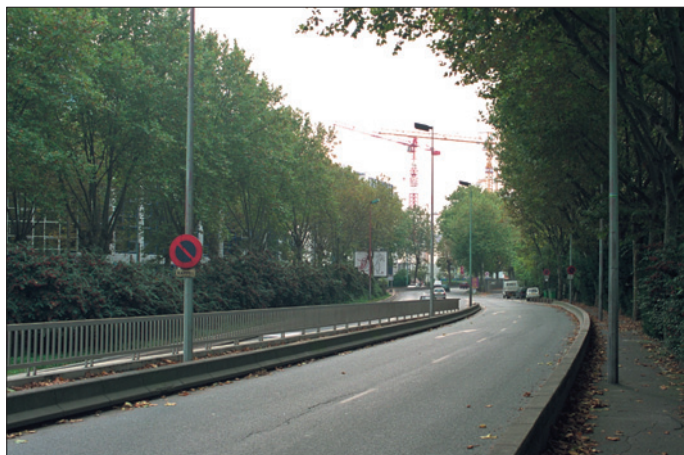
Quai de Stalingrad (Issy-Les-Moulineaux), à l'aval du pont d'Issy. Vue vers l'aval. Sortie du passage dénivelé. Ambiance routière. Trottoir étroit.
