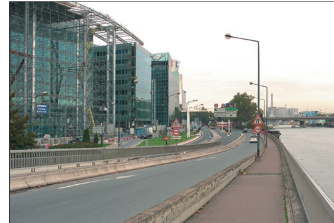
Quai du Point du Jour - RD1, vers l'amont. Passage routier dénivelé à l'amont de la tête de pont du pont d'Issy.
