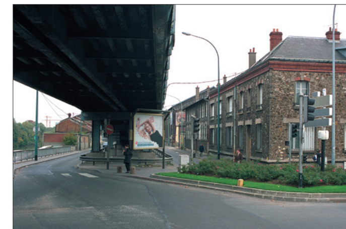
Quai de Stalingrad (Issy-Les-Moulineaux) sous l'autopont de Billancourt . Vue vers l'amont.
