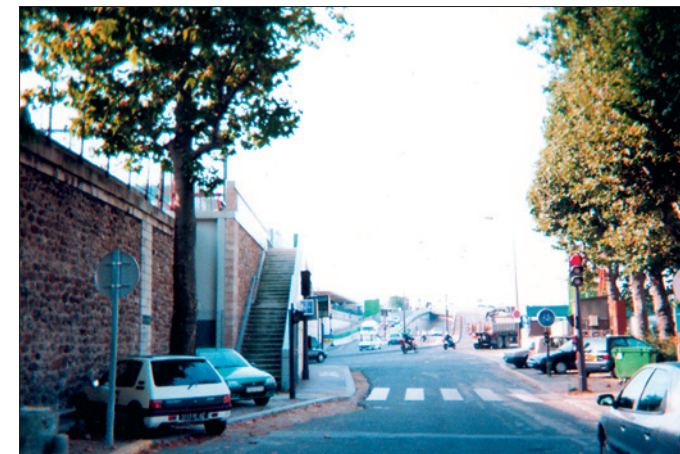
Port de Javel Bas, accès des berges au carrefour Citroën Leblanc, escalier de descente de la passerelle piétonne le long du RER.
