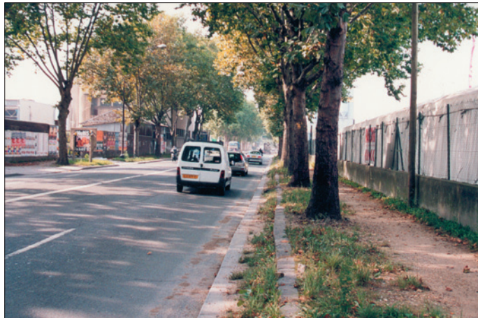
Quai du président Roosevelt (Issy-Les-Moulineaux) à l'aval du bd périphérique, vue vers l'aval. Trottoir dégradé avec une double bordure.
