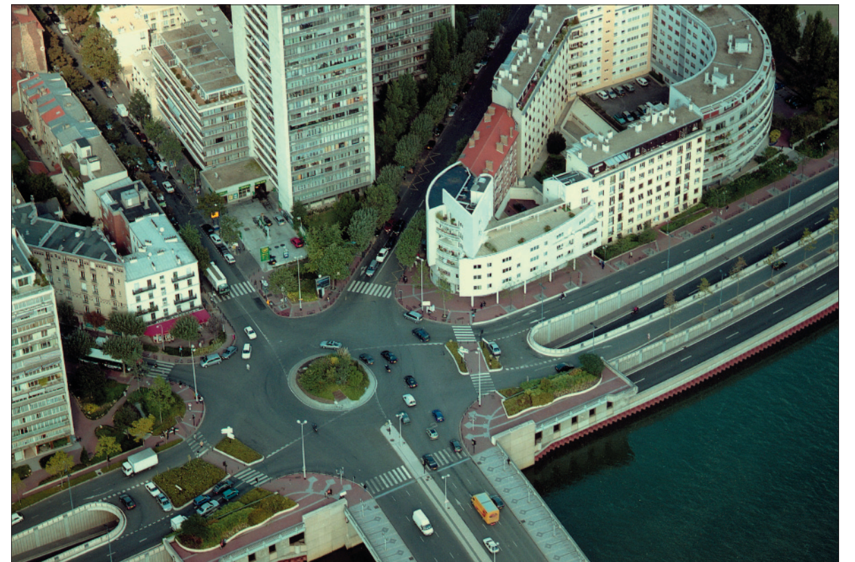
Détail de la tête du pont de Billancourt (Boulogne-Billancourt).
