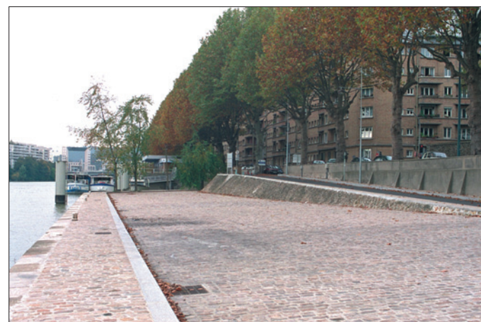
Port large à Boulogne-Billancourt. Rampe d'accès au quai. Port industriel au second plan (poste de transit). Vue vers l'aval.
