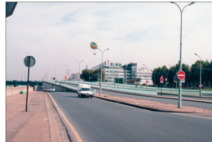
Quai d'Issy-Les-Moulineaux (Paris 15 e ), en aval du pont du Garigliano. Vue vers l'amont. Rampes d'accès au pont. Ambiance routière.
