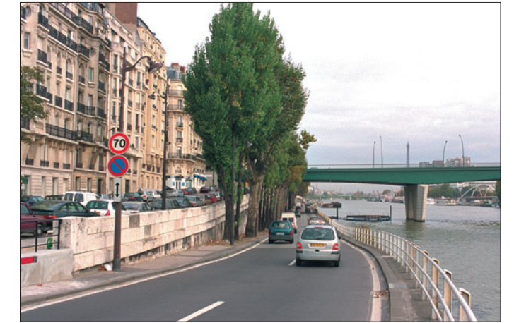
Départ de la voie G. Pompidou sur la berge basse (Paris 16 e ). Vue vers l'amont (pont du Garigliano).
