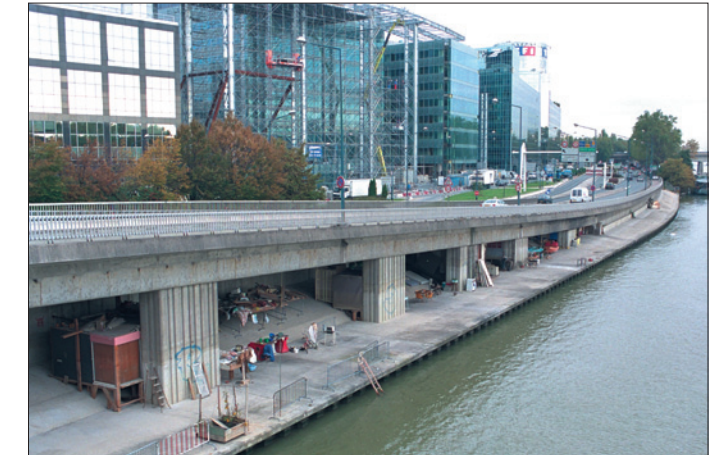
Berge à Boulogne-Billancourt. Occupation précaire sous la rampe amont du pont d'Issy. Vue vers l'amont.
