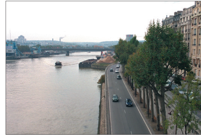
Voie G. Pompidou sur la berge basse et port du Point du Jour (Paris 16 e ). Vue depuis le pont du Garigliano, vers l'aval.
