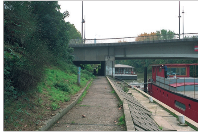
En amont et vers le pont d'Issy, promenade piétonne sur la berge.
