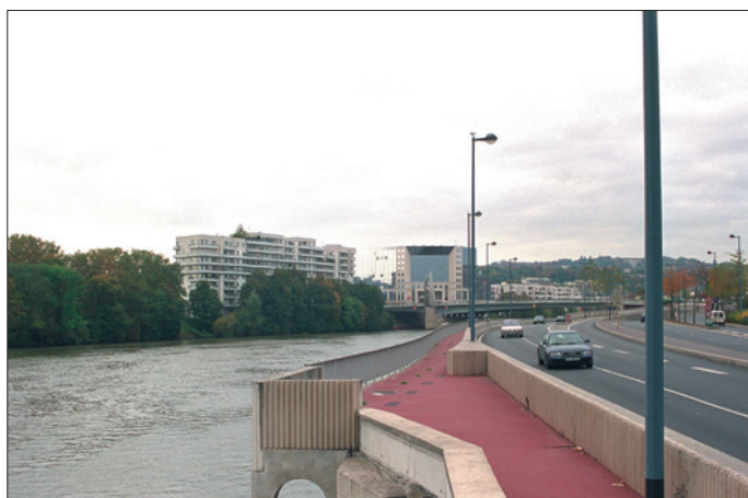
Quai du Point du Jour - RD1 (Boulogne-Billancourt), vers l'aval (Pont de Billancourt).
