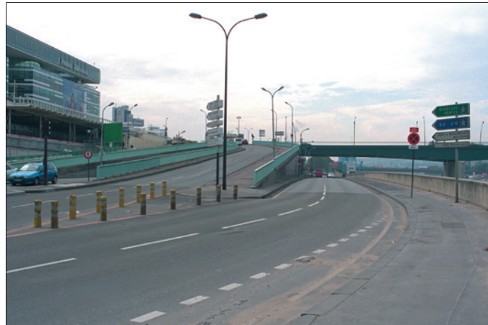
Quai André Citroën (Paris 15 e ) axe rouge à la sortie du port de Javel Bas, vers l'aval (pont du Garigliano). Aménagement en cours d'une bande cyclable côté bâti.
