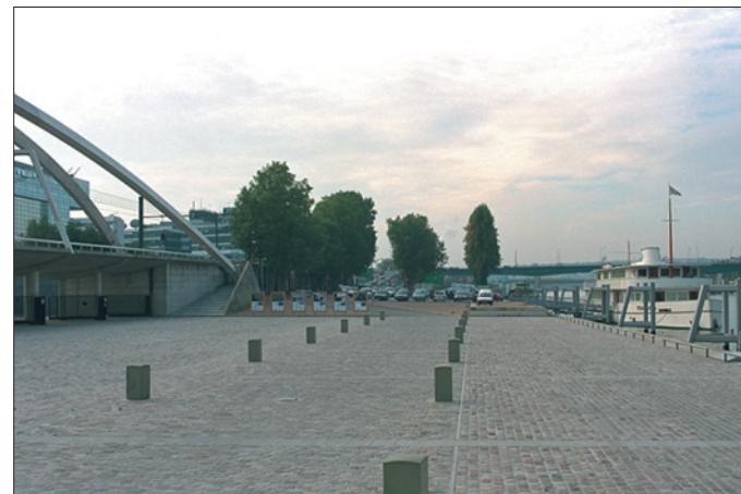
Port de Javel Bas (Paris 15 e ) débouché du Parc André Citroën (aménagé en 1999).
