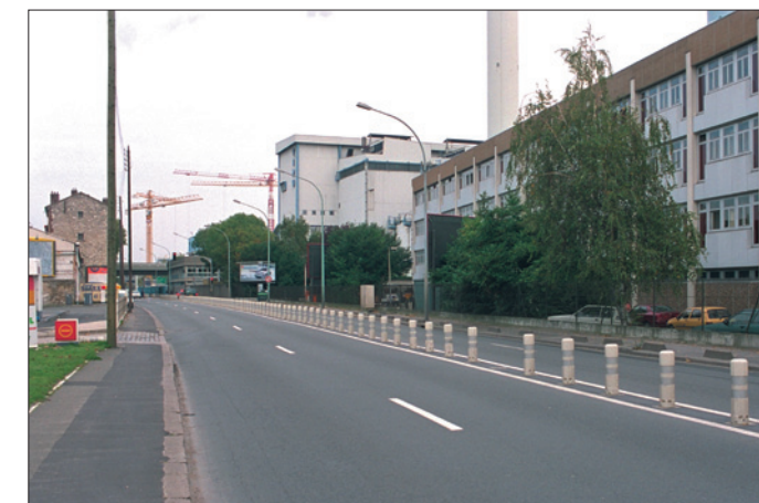
Quai de Stalingrad (Issy-Les-Moulineaux), en amont du pont de Billancourt vue vers l'amont. Usine de la Tiru et ZAC Bords de Seine en chantier.
