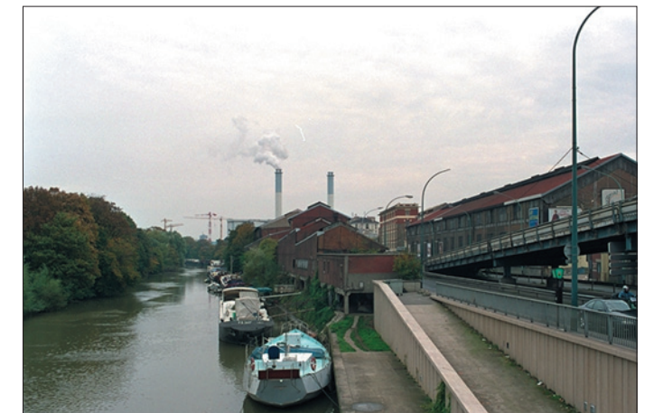
Bras d'Issy-Les-Muolineaux en amont du pont de Billancourt, rampe d'accès au quai, vue vers l'amont.
