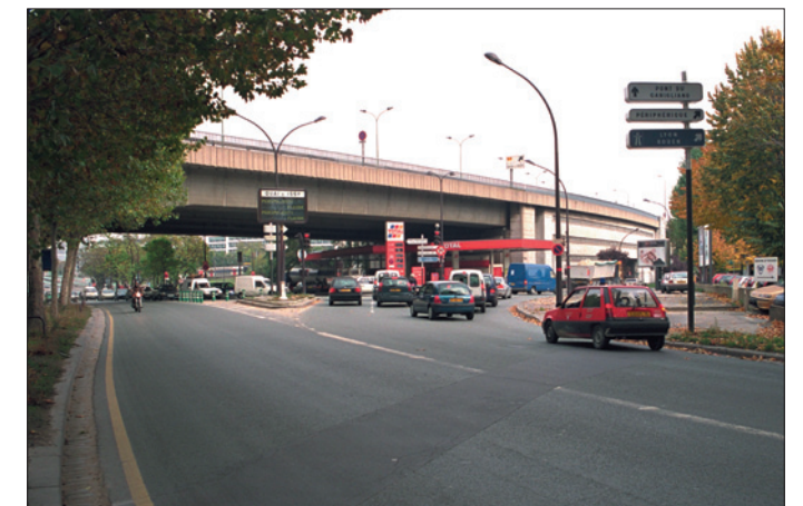
Quai d'Issy-Les-Moulineaux (Paris 15 e ), en aval du bd périphérique, vue vers l'amont. Bretelle d'accès au BP.
