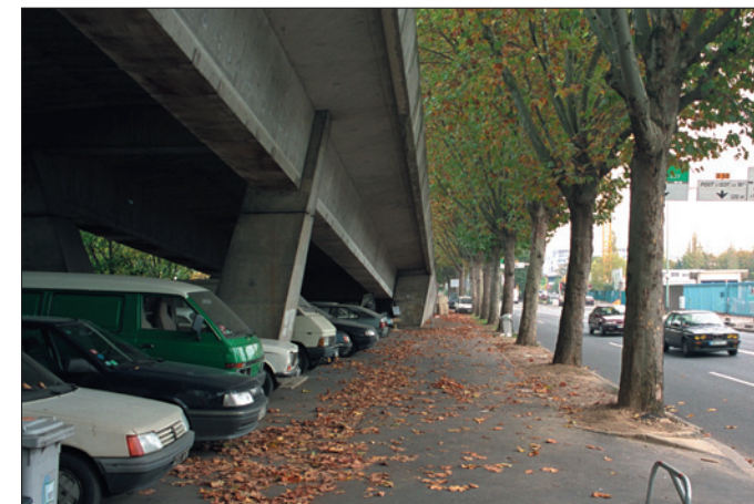
Quai de Stalingrad (Issy-Les-Moulineaux). Vue vers l'amont. Rampe d'accès pour les camions de la TIRU.
