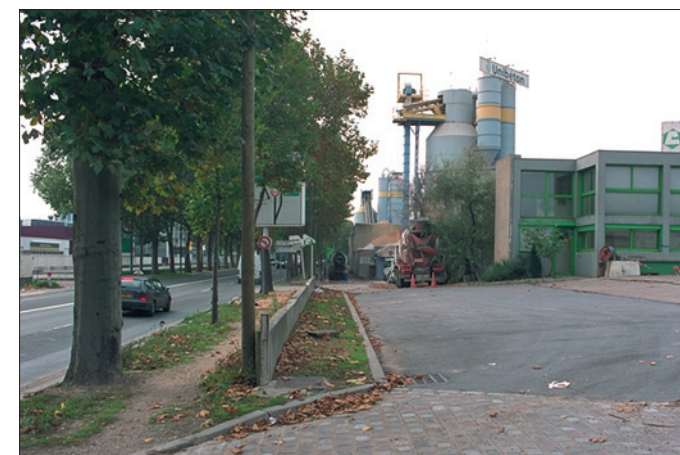
Accès au port d'Issy-Les-Moulineaux en aval du bd périphérique, vers l'aval.
