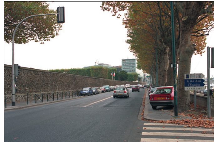
Quai du Point du Jour - RD1, vers l'amont, au droit du cimetière. Accès à la berge. Stationnement illicite sur trottoir.
