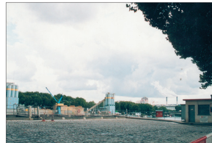
Port de la Petite Arche, poste de transit (Paris 16 e ). Vue sur les installations industrielles du port d'Issy-Les-Moulineaux en rive gauche.
