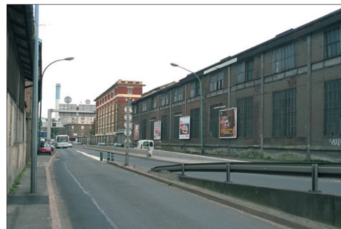
Quai de Stalingrad (Issy-Les-Moulineaux), en amont du pont de Billancourt, vue vers l'amont. Rampe d'accès à l'autopont de Billancourt. ZAC Quai des Chartreux.
