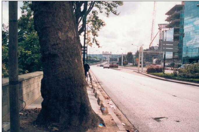
Quai du Point du Jour - RD1 (Boulogne-Billancourt), vers l'aval. Trottoir étroit. Ambiance routière. Circulation des vélos difficile.
