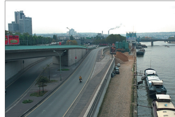
Port Victor (Paris 15 e ) en aval du pont du Garigliano, sable stocké en vrac, vue vers l'aval.
