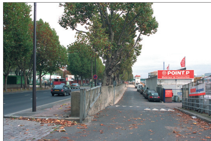
Port du Point du Jour (Paris 16 e ). Accès du quai. Vue vers l'amont.
