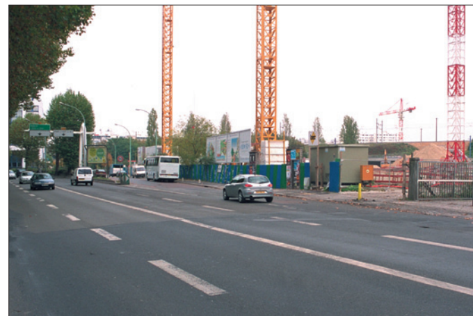
Quai de Stalingrad (Issy-Les-Moulineaux), à l'aval du pont d'Issy. Vue vers l'amont. ZAC Bords de Seine en chantier. Départ de la rue C. Desmoulins vers la rue H. Farman et Paris.
