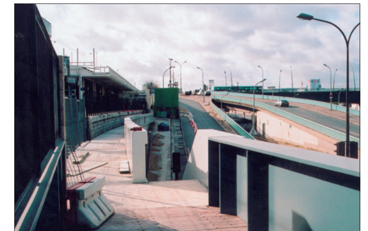
Débouché de la passerelle piétonne sur le trottoir au droit de la gare du RER bd Victor. Aménagement en cours de la bande cyclable.
