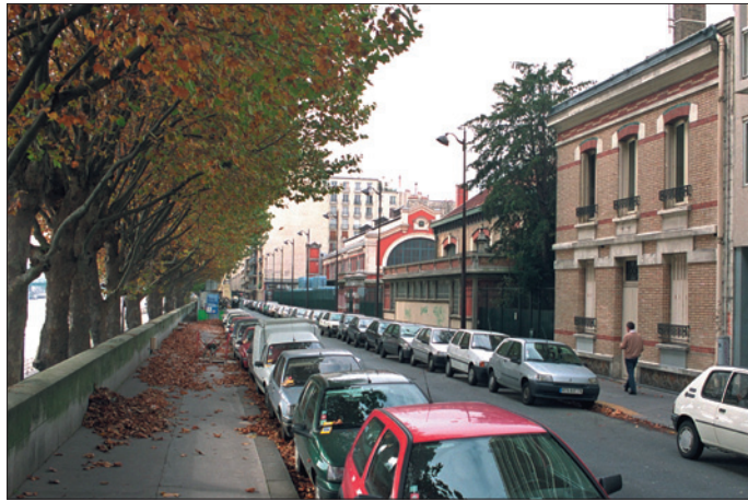
Quai Louis Blériot (Paris 16 e ) à l'aval du pont Mirabeau, au droit des terrains de l'usine des eaux. Voie de desserte.
