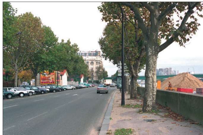
Quai Saint-Exupéry - Voie G. Pompidou (Paris 16 e ) vers l'amont, au droit du port du Point du Jour. Stationnement en épi. Trottoir dégradé.
