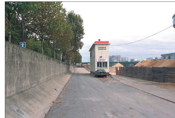
Port du Point du Jour (Paris 16 e ). Voie circulée le long du mur de quai. Vue vers l'amont.
