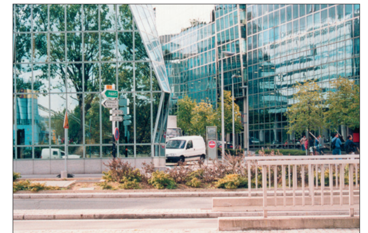
ZAC du Point du Jour (Boulogne-Billancourt). Aménagement routier de la RD 1.
