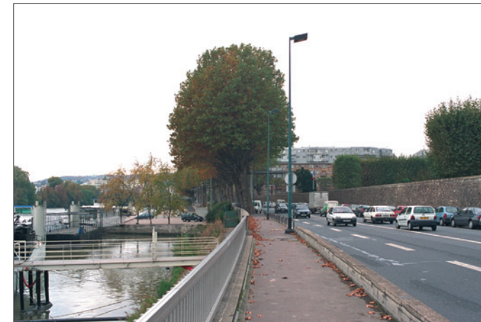
Transition entre le berge étroite et le port large à Boulogne-Billancourt. Aménagement d'une escale. Vue vers l'aval.
