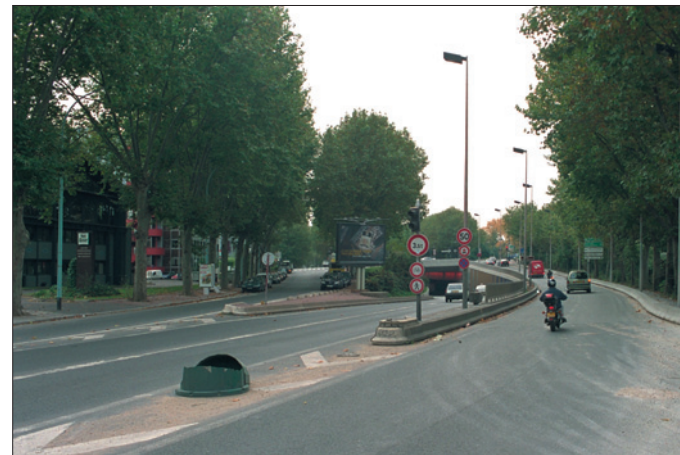
Quai du président Roosevelt (Issy-Les-Moulineaux), en amont du pont d'Issy. Vue vers l'aval. Passage dénivelé. Sortie du port d'Issy-Les-Moulineaux.
