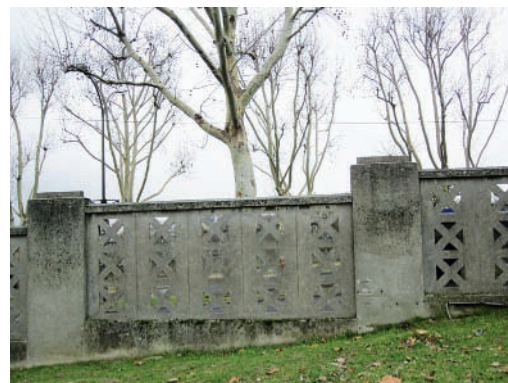
Mur en béton ajouré
