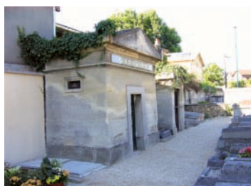
Épinay-sur-Seine, cimetière communal, Chapelle transformée en ossuaire
