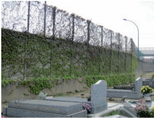
Palissade en béton végétalisée
