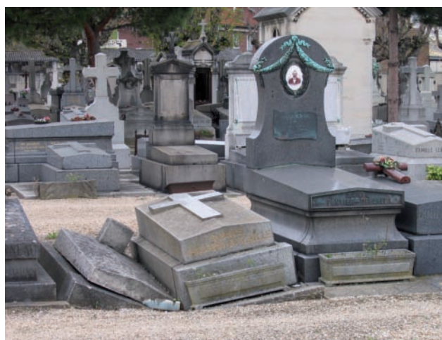
Saint-Denis, cimetière communal Affaissement lié au sous-sol
