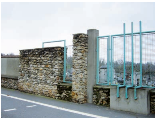
Mur ajouré par des grilles
