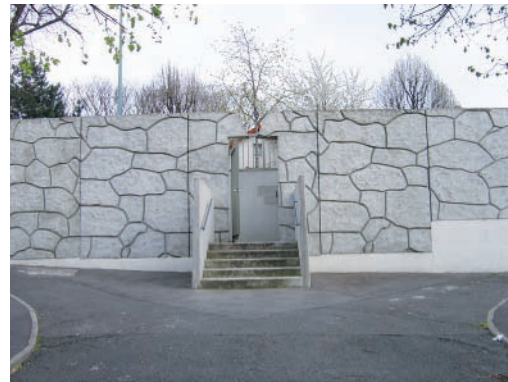
Mur en béton
