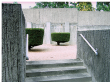
Extension nord-est, détail
