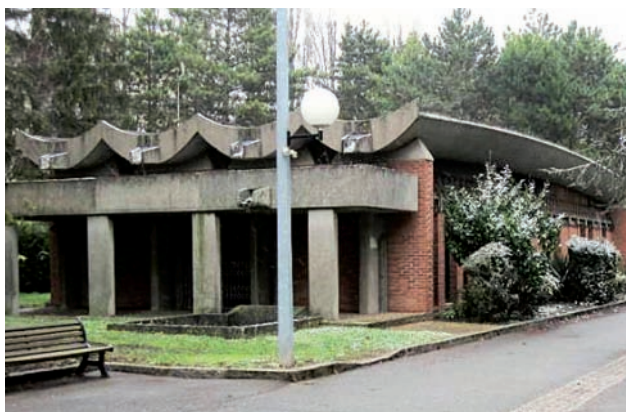
Bâtiment N, entrée nord, à réhabiliter
