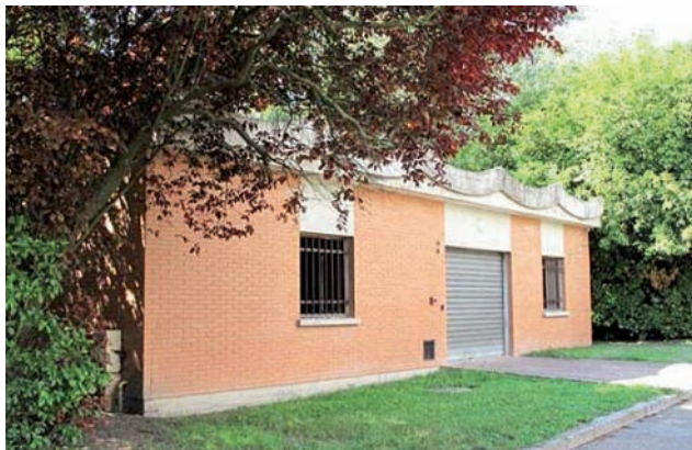
Ancien four : démolition à envisager
