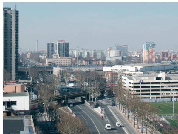
Vue sur le boulevard Ney depuis les entrepôts Calberson.
