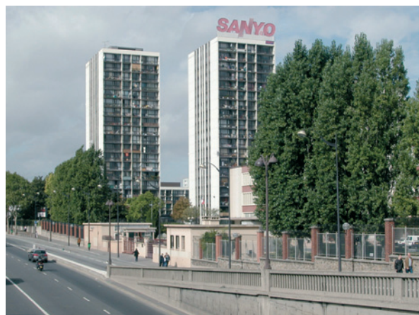
Immeubles du boulevard Ney.
