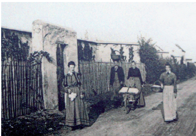
La rue St Antoine en 1900, le mur de clôture en retrait ménage un espace en rapport avec la rue
