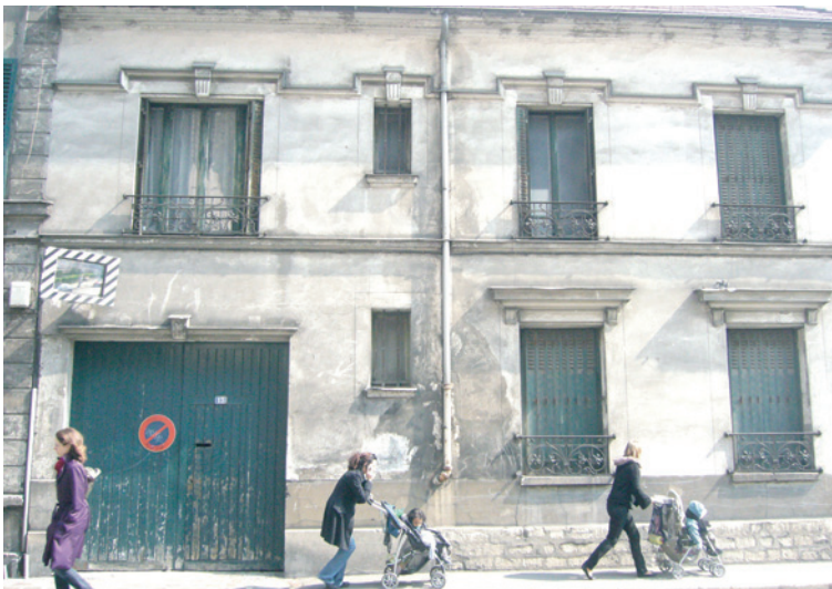
Habitat ancien, rue Raspail à Ivry-sur-Seine
