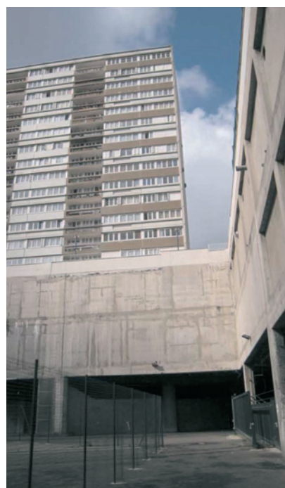
Vue depuis le niveau de la gare de FRET vers la barre Squaw Valley
