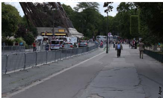
Avenue Gustave Eiffel - trottoirs
