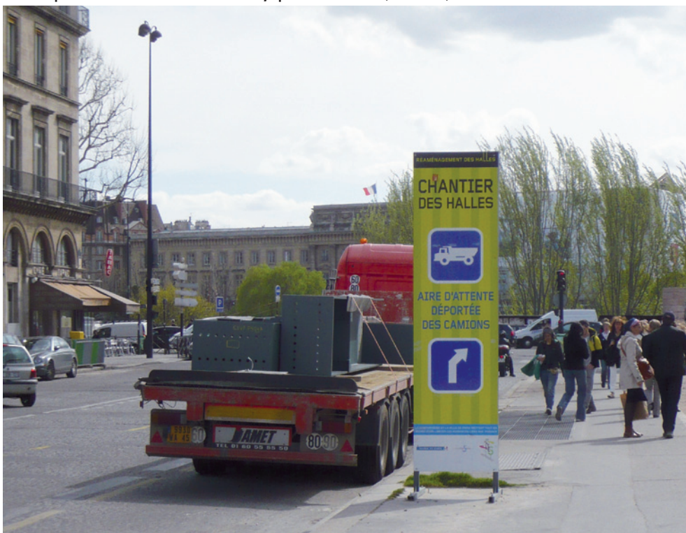
Aire déportée du chantier des Halles, quai du Louvre (Paris 1 er )
