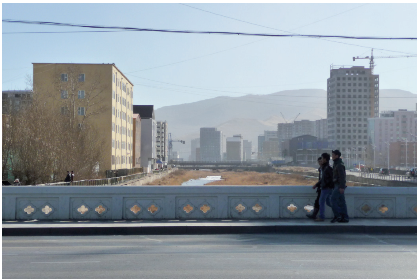
Vue vers le sud de la ville au croisement de la rivière Selbe et de l'avenue de la Paix
