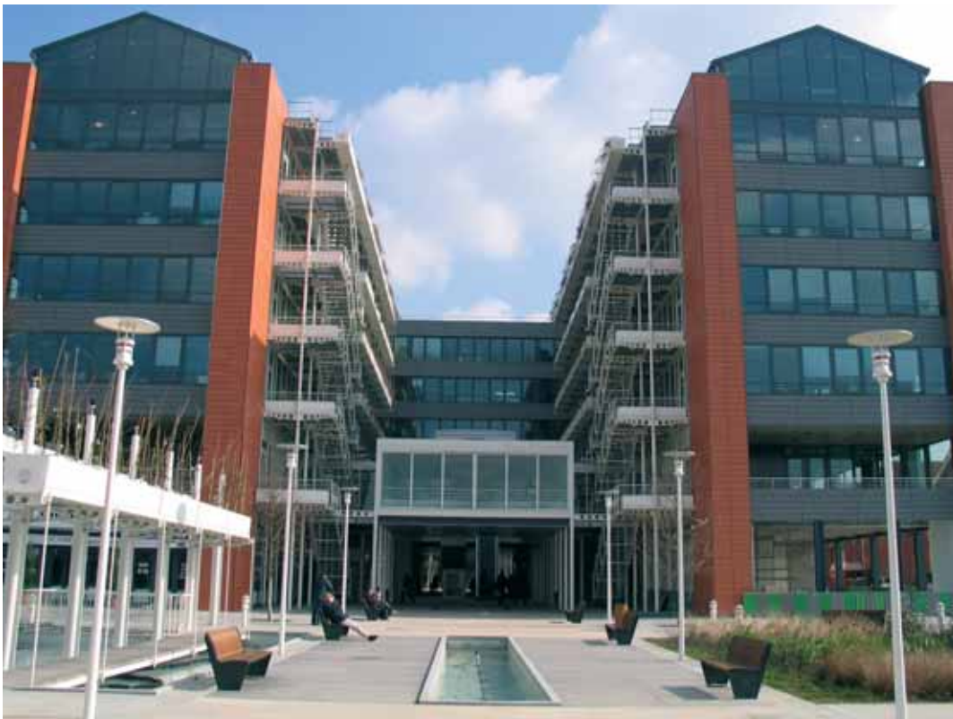
Première tranche du nouveau complexe des Entrepôts des Magasins Généraux, à Aubervilliers.
