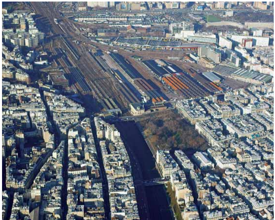
La gare des Batignolles : un vaste enclos au milieu des quartiers denses du 17 e arrondissement.
