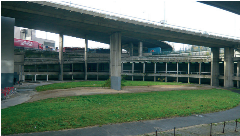
Bretelle d'accès des parkings du centre commercial
