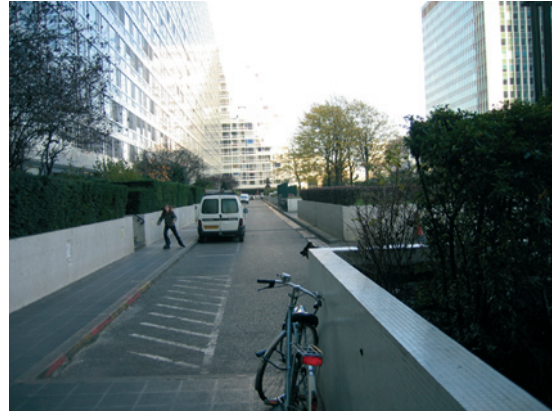
« Rue » en hauteur le long de l'immeuble Dubuisson
