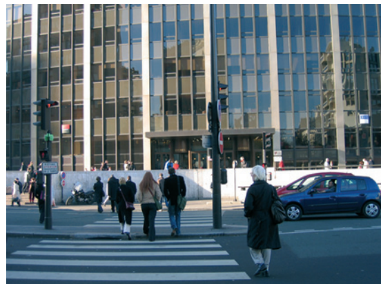
Traversée butant sur un mur au pied de la tour Montparnasse
