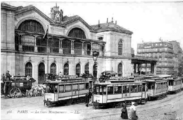
La première gare Montparnasse
