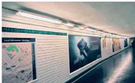
*Exemple de luminaires en implantation latérale et de serrurerie avec réglottes intégrées*
