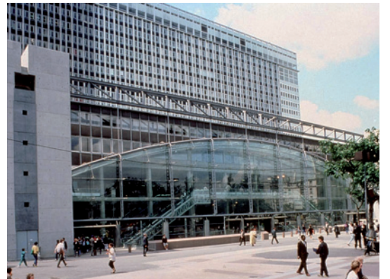
Gare Montparnasse, Porte Océane, milieu des années 90
