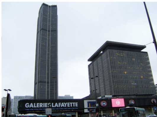
Ensemble immobilier Maine-Montparnasse (début des années 70)
