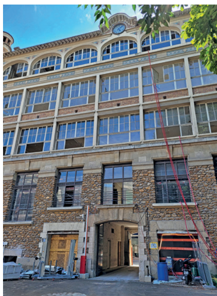
Galileo Global Education s'installera en 2025 au cœur du 5 e arrondissement de Paris dans les anciens bâtiments d'AgroParisTech (chantier du promoteur Hertel).
