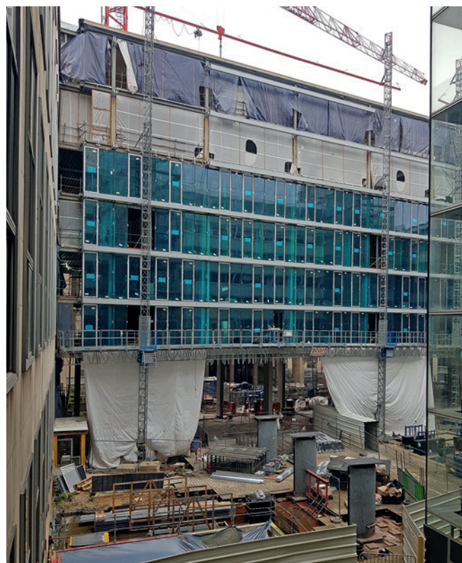
Travaux de rénovation et d'agrandissement de l'université Paris Dauphine-PSL, Paris 16 e
