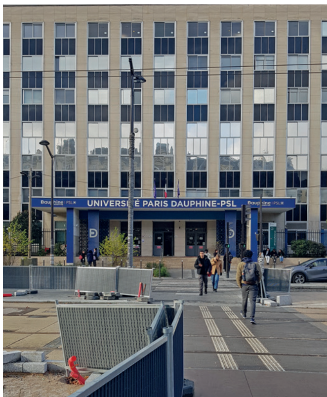
Travaux devant l'université Paris Dauphine-PSL en vue de l'arrivée du Tramway T3b prévue au printemps 2024, Paris 16 e
