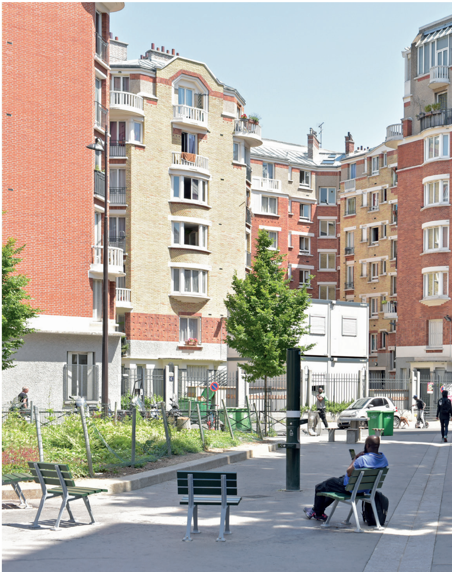
Rue Émile Blémont, HBM de la cité Blémont, Paris 18 e
