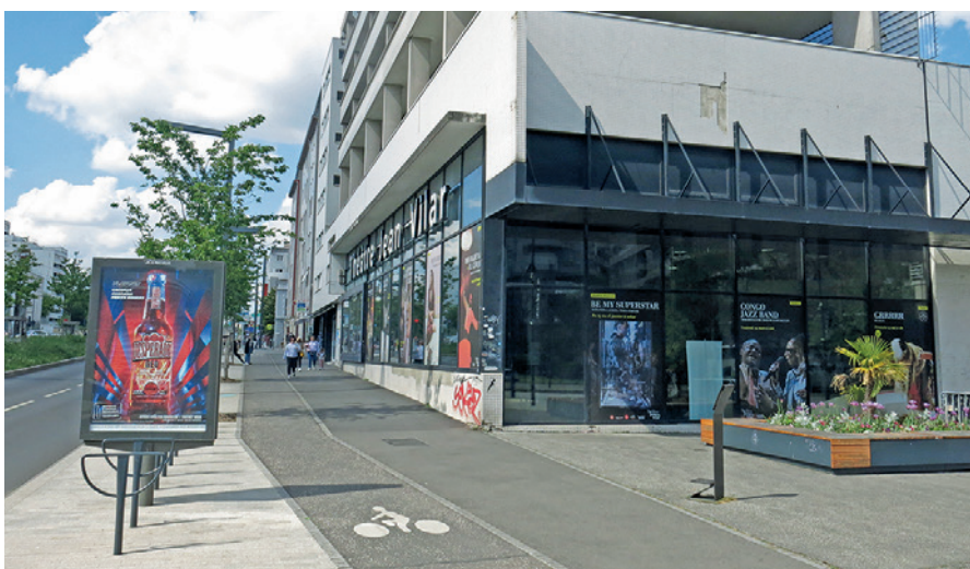
Bande cyclable sur trottoir et stationnement vélo, avenue Youri Gagarine, quartier de gare Vitry Centre
