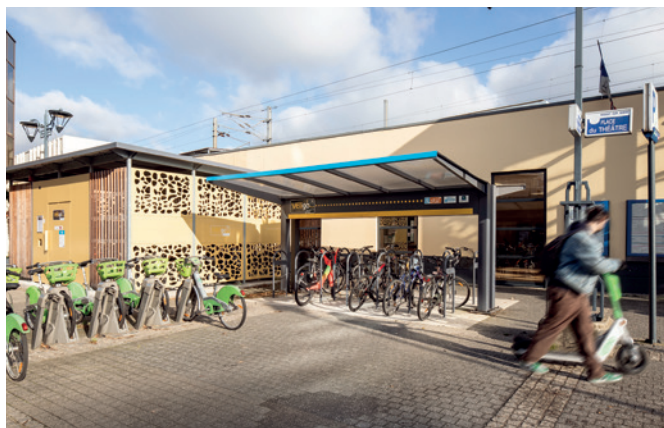
Abris IDFM - Gare du RER E à Nogent-Le-Perreux
